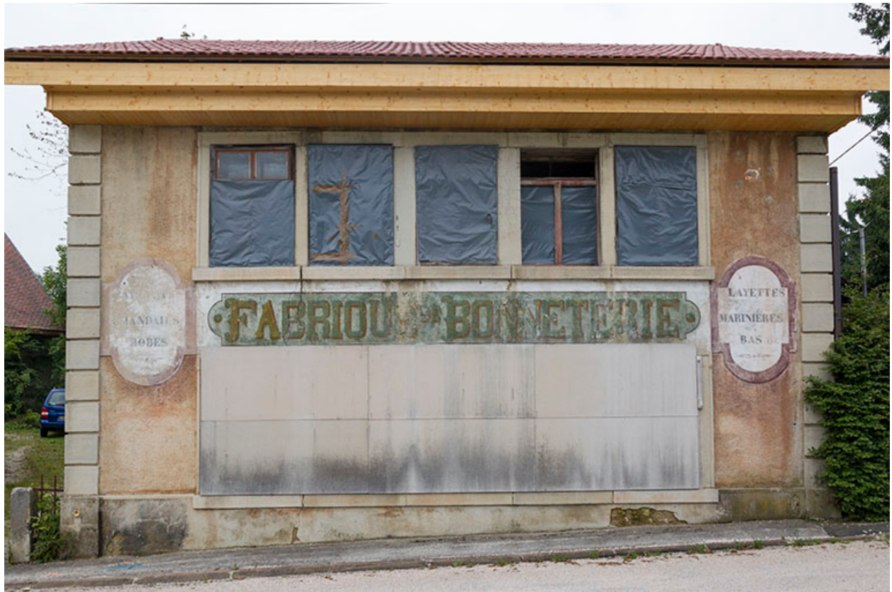
Usine : façade antérieure.
