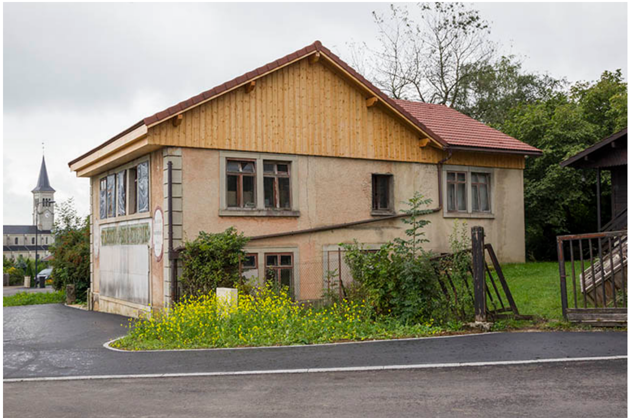
Usine : façade latérale droite (vue d'ensemble).
