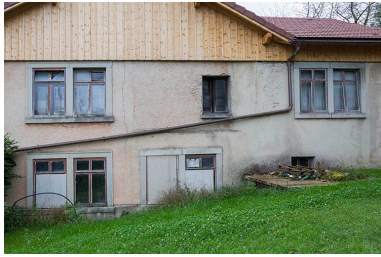
Usine : façade latérale droite. Phot. Yves Sancey IVR43_20132501393NUC2A
