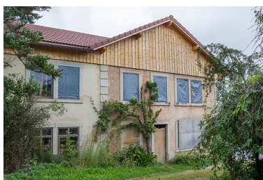
Usine : façade latérale gauche (entrée). Phot. Yves Sancey IVR43_20132501394NUC2A
