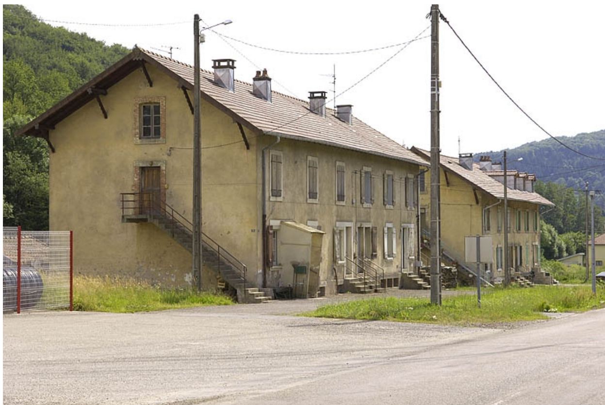
Vue d'ensemble des logements ouvriers.
