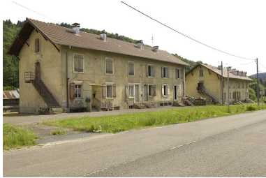
Logements ouvriers depuis le nord-est. Phot. Jérôme Mongreville IVR43_20057000338NUCA
