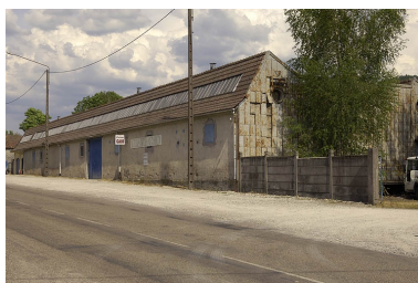
Travées nord de l'atelier de fabrication (tissage). Phot. Jérôme Mongreville
