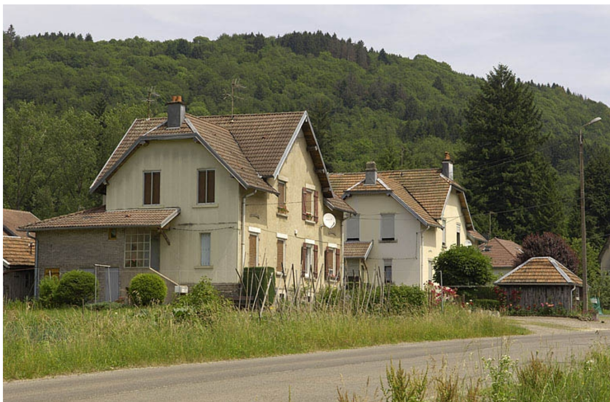
Vue d'ensemble des logements de contremaître.
