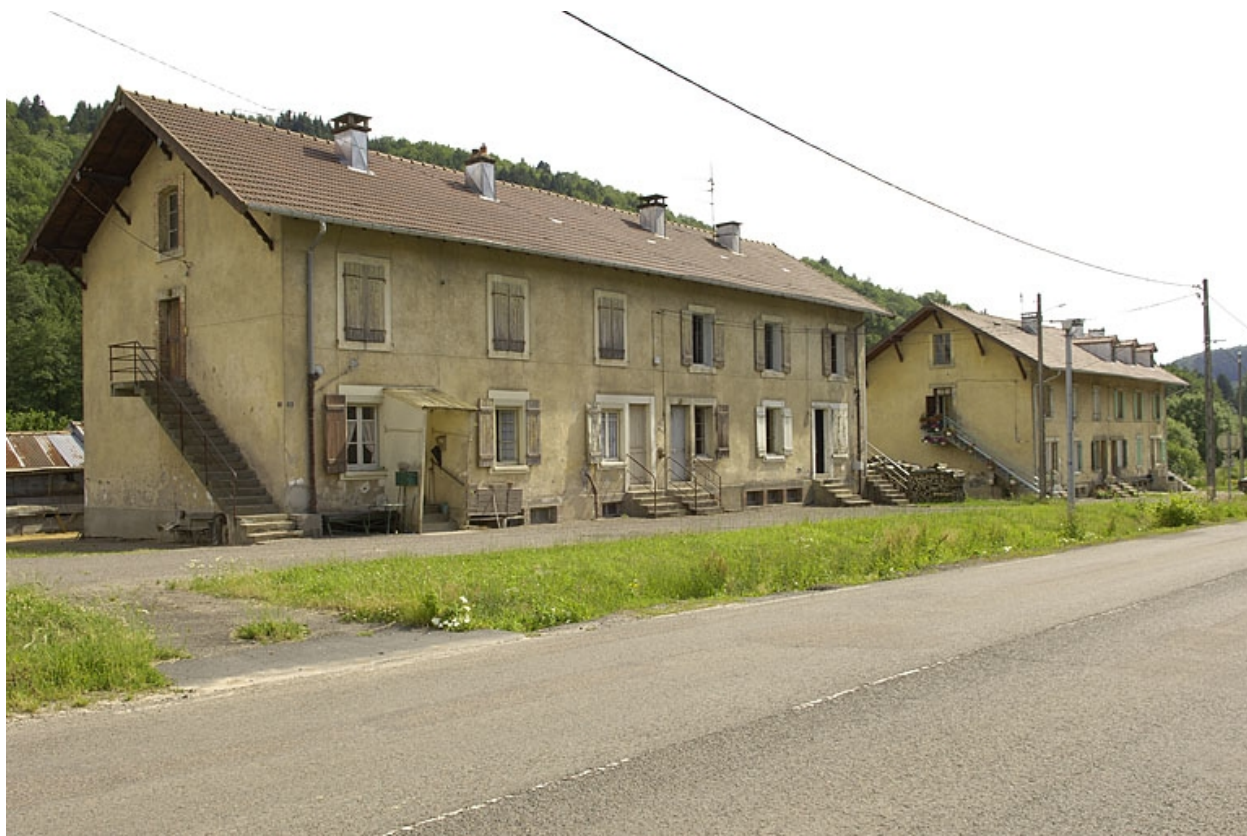
Logements ouvriers depuis le nord-est.
