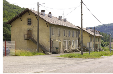
Vue d'ensemble des logements ouvriers. Phot. Jérôme Mongreville IVR43_20057000337NUCA
