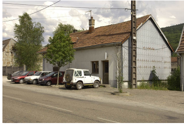
La conciergerie vue de trois quarts. Phot. Jérôme Mongreville IVR43_20057000334NUCA
