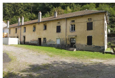
Façade occidentale des logements ouvriers.
