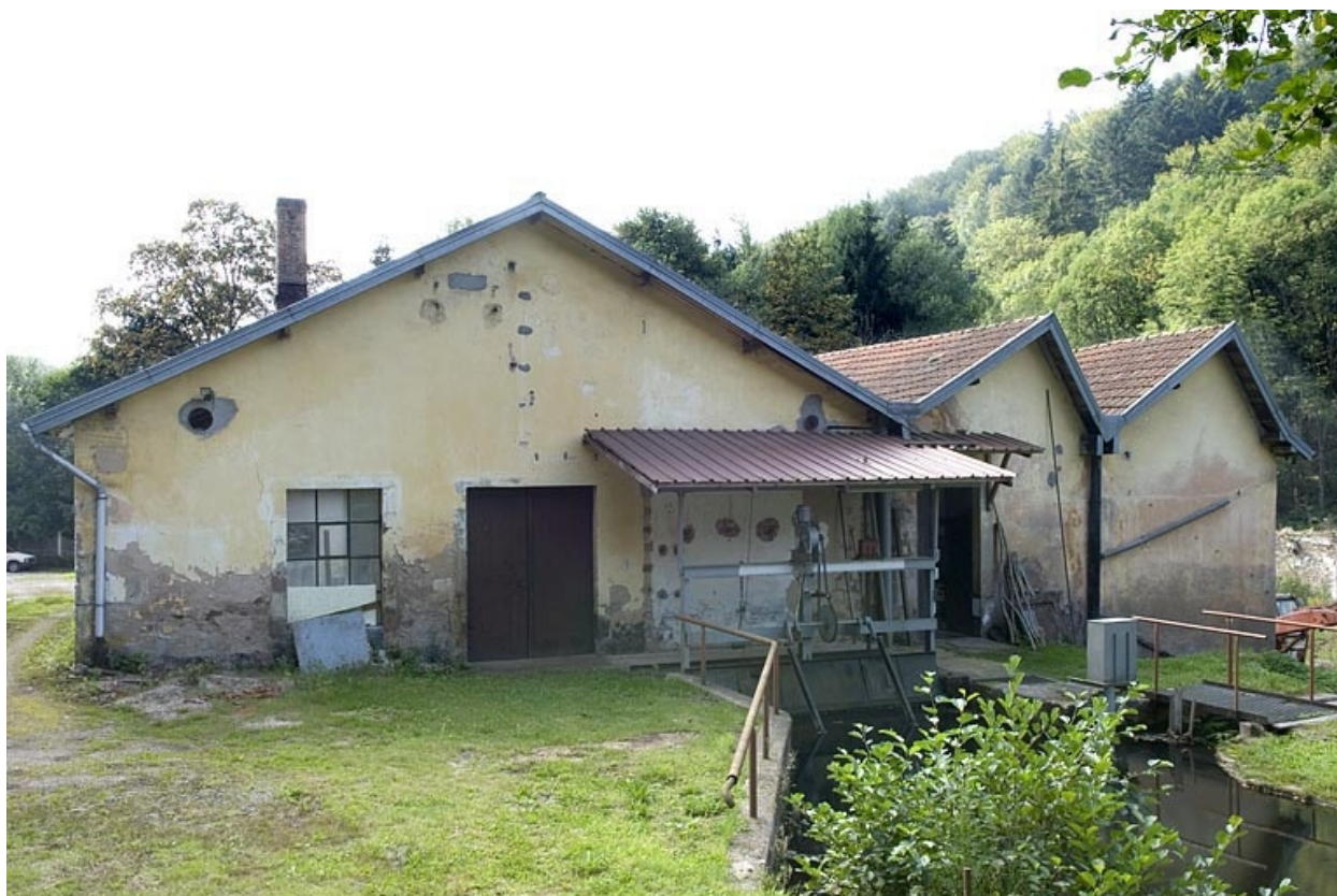
Pignon nord de l'atelier de fabrication.
