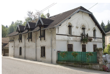
Logement du directeur. Vue depuis la route. Phot. Jérôme Mongreville IVR43_20067000714NUCA
