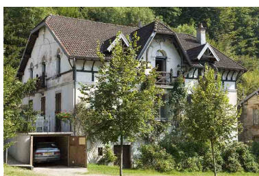
Logement du directeur. Façade postérieure. Phot. Jérôme Mongreville IVR43_20067000729NUCA
