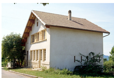
La fromagerie de Larrivoire reconstruite après-guerre. Phot. Laurent Poupard IVR43_19903900430ZA
