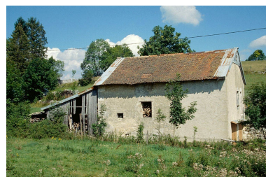
L'ancien chalet de fromagerie de Viry. Phot. Laurent Poupard IVR43_19903900435ZA
