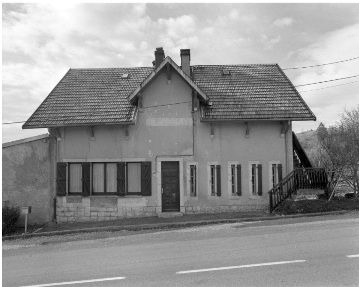
Façade antérieure du chalet du Rosay.
