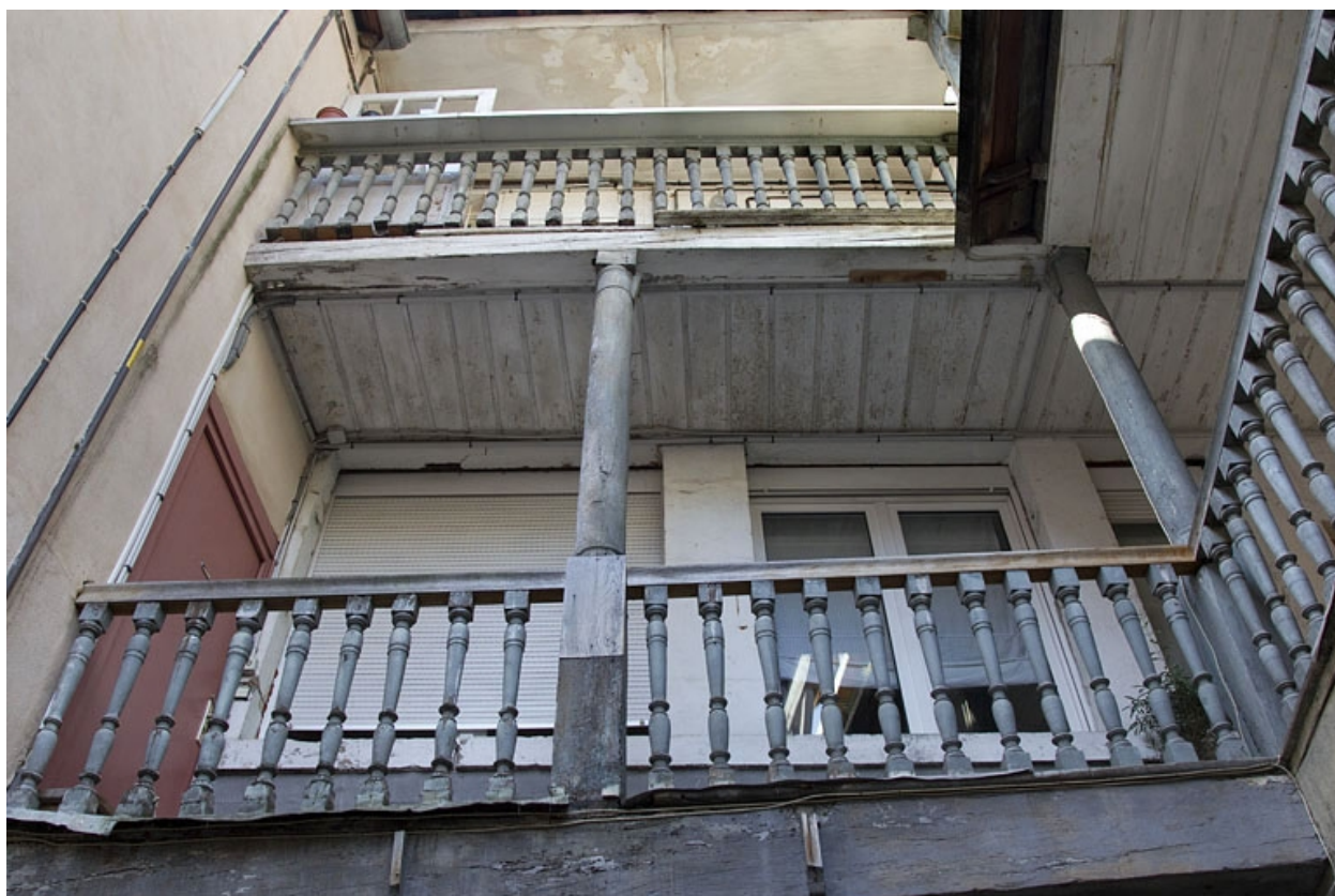
Escalier extérieur : détail des coursières, de face.
