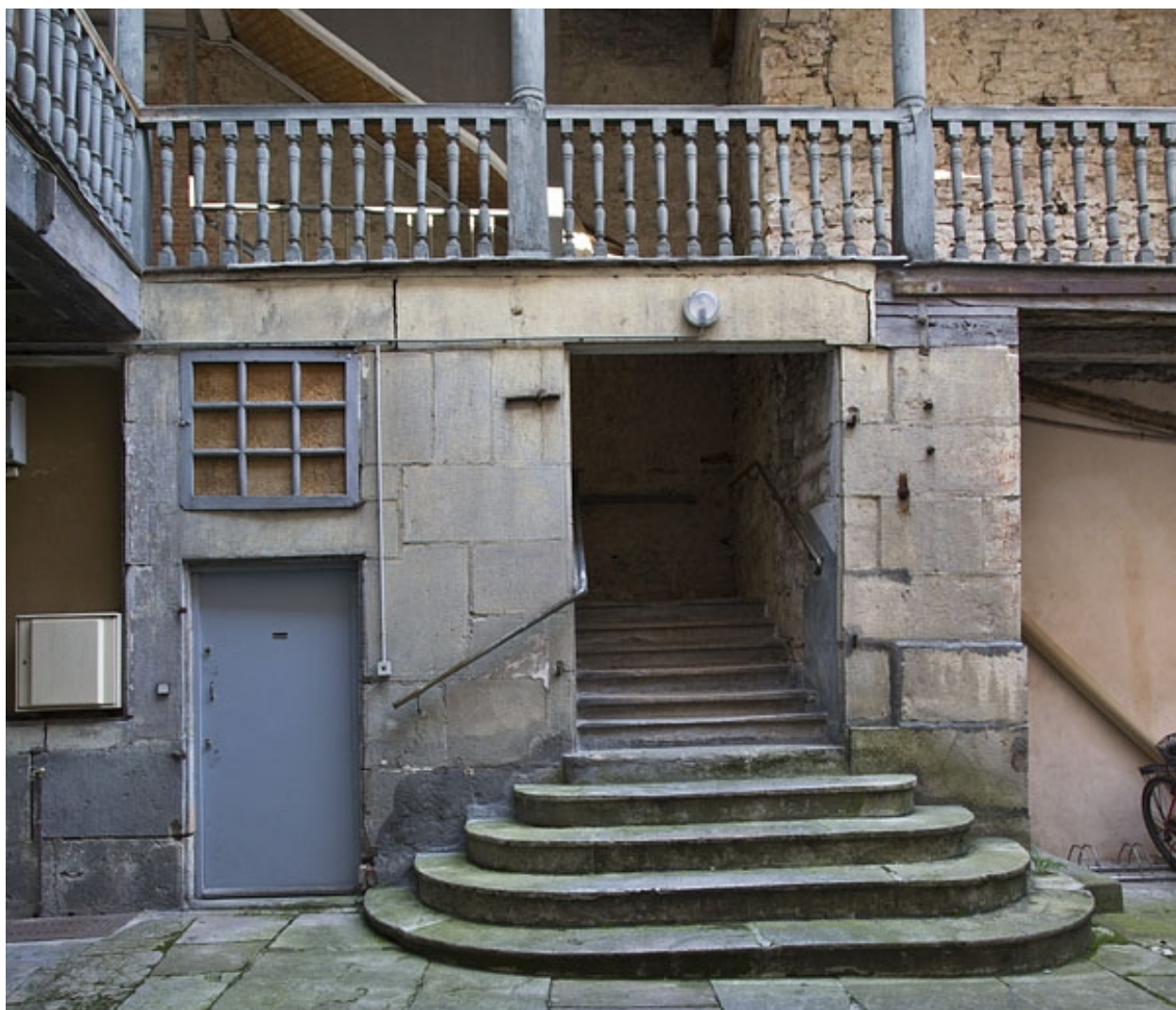
Escalier extérieur : détail du départ de l'escalier.
