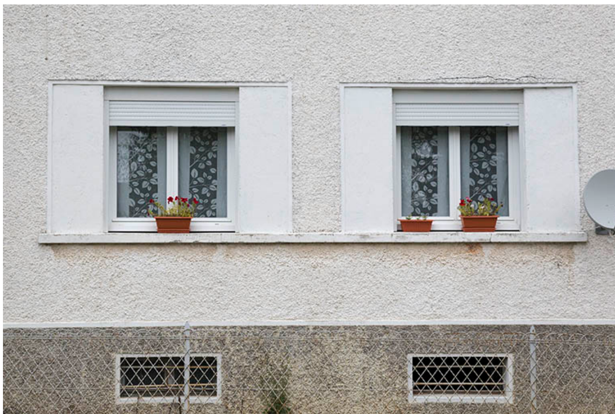
Façade antérieure : anciennes fenêtres d'atelier.
