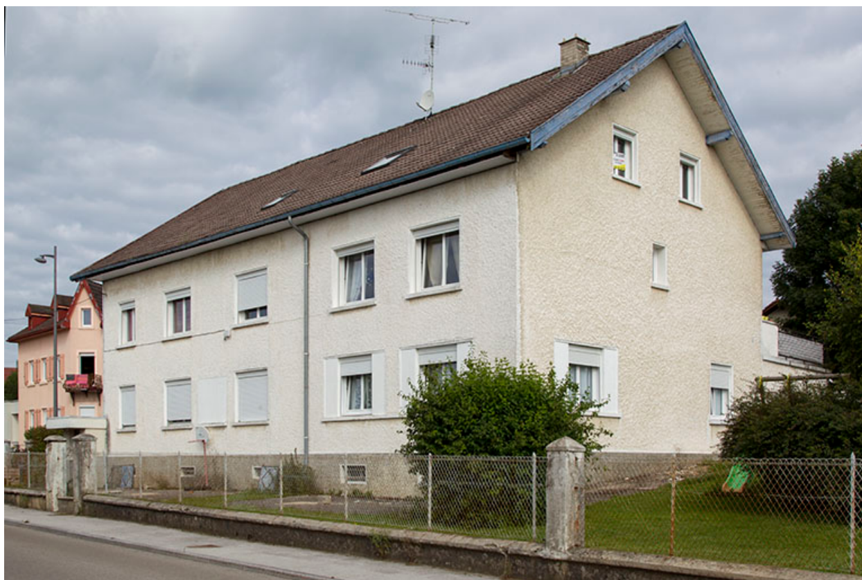
Façades antérieure et latérale droite.
