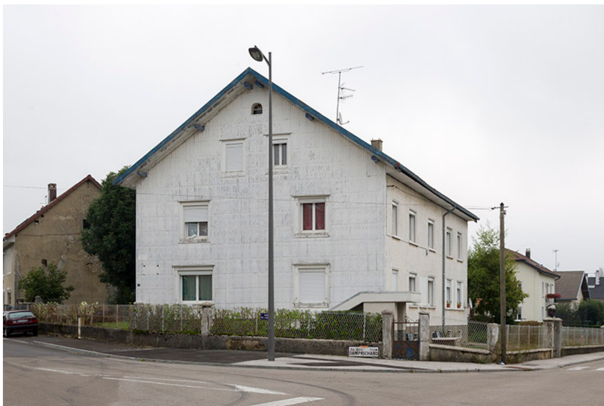
Façades antérieure et latérale gauche.
