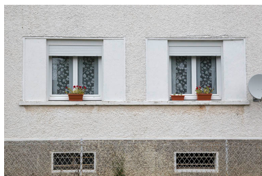
Façade antérieure : anciennes fenêtres d'atelier.
