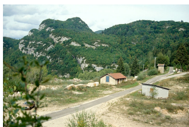
Bâtiments depuis le sud- est. Cantine et vestiaire à gauche, atelier de réparation à droite. Phot. Laurent Poupard IVR43_19903900589ZA
