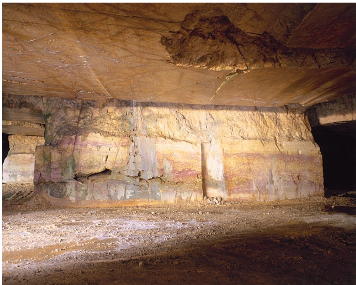
Intérieur, partie nord-est, détail d'un pilier montrant la stratigraphie des couches de marbre.
