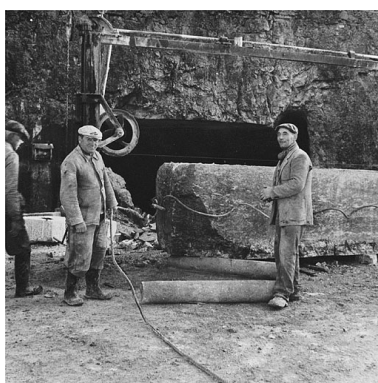
Tirage d'un bloc sur le chantier : mise en place du câble.
