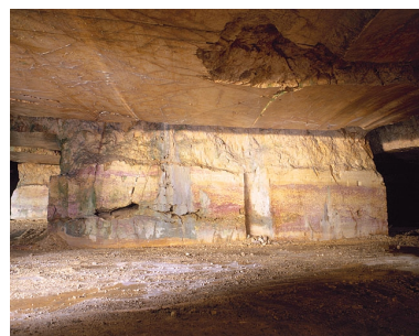
Intérieur, partie nord-est, détail d'un pilier montrant la stratigraphie des couches de marbre. Phot. Yves Sancey IVR43_19973900152XA
