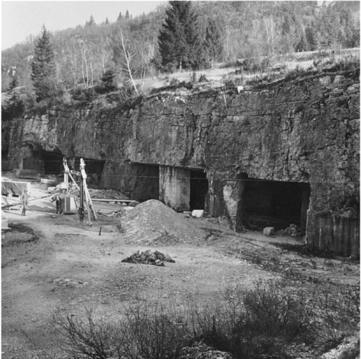
Chantier et entrées de la carrière souterraine.
