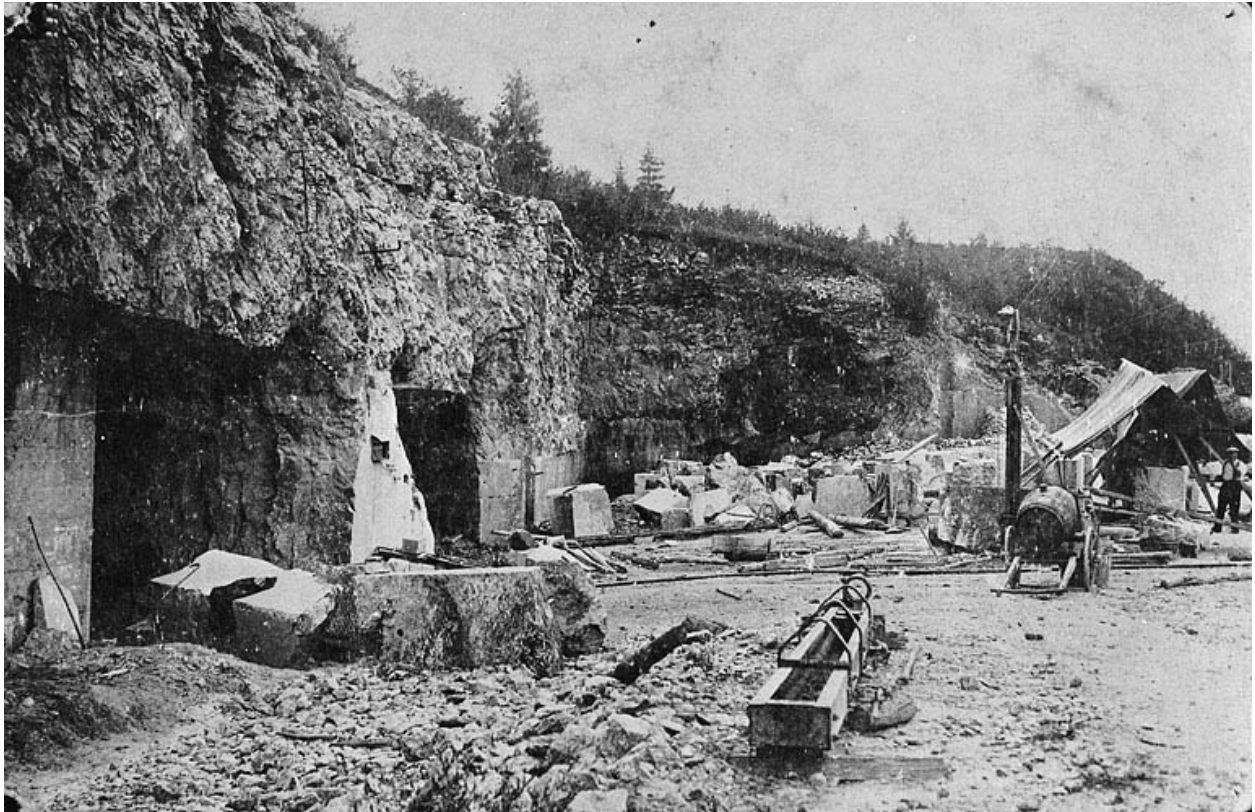
Chantier et entrées de la carrière souterraine.
