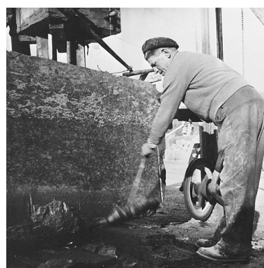
Suppression des aspérités sur la face d'un bloc taillé au fil hélicoïdal (vue rapprochée).
