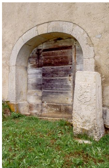
Borne frontalière : vue d'ensemble. Phot. Yves Sancey IVR43_19993900198ZA
