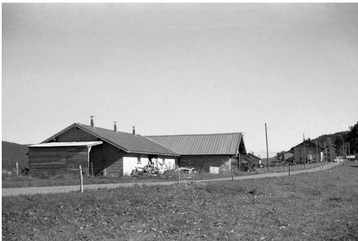
Fromagerie située au lieudit Les Berthets.
