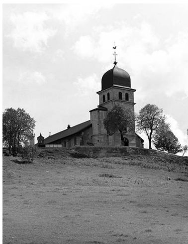
Eglise paroissiale Saint-Pierre. Phot. Jérôme Mongreville IVR43_20003900645X
