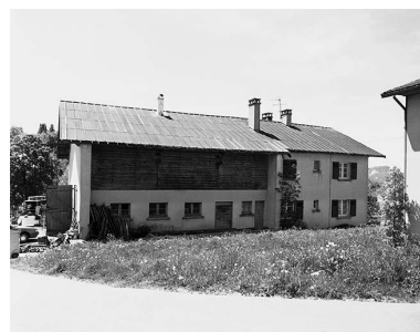
Façade antérieure d'une ferme reconstruite après 1945. Phot. Jérôme Mongreville IVR43_20013900438X
