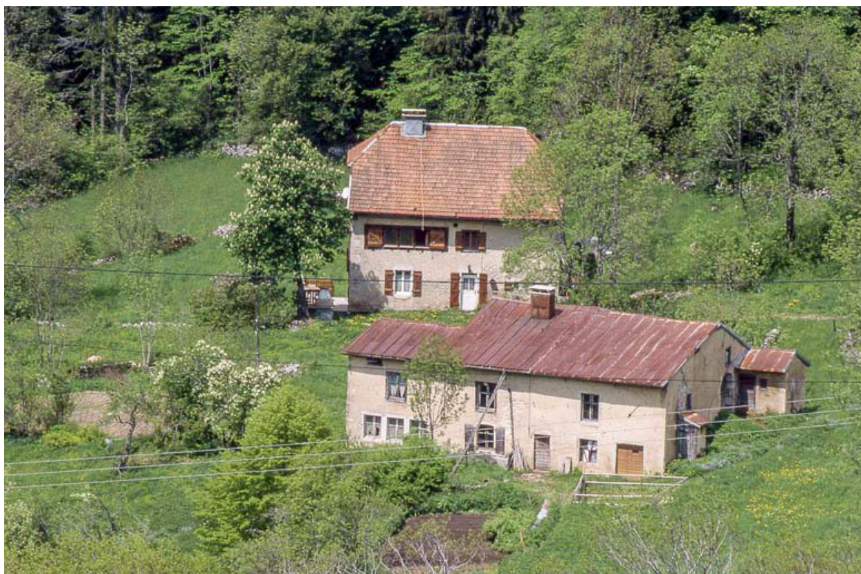
Ferme située au lieudit Chez Bugy.
