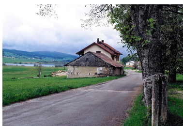
Fromagerie située route du Lac. Phot. Yves Sancey IVR43_19993900179ZA
