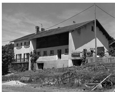
Façade postérieure d'une ferme reconstruite après 1945. Phot. Jérôme Mongreville IVR43_20013900439X
