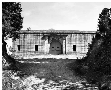
Fort du Risoux : façade antérieure, vue éloignée. Phot. Jérôme Mongreville IVR43_20013900426X
