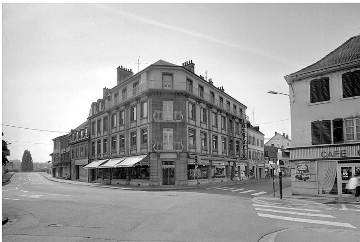
Immeuble construit à son emplacement.
