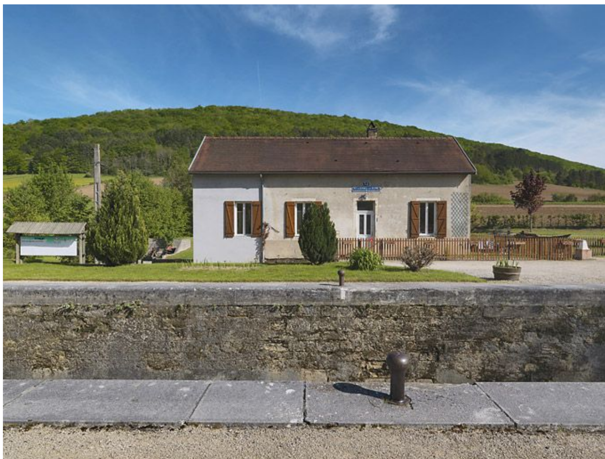
Maison éclusière de face.
