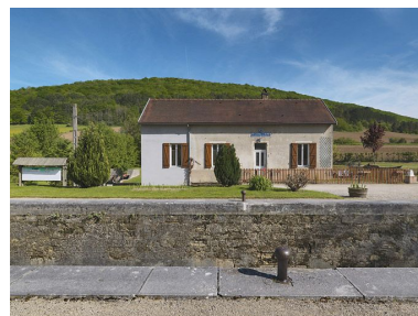
Maison éclusière de face. Phot. Thierry Kuntz IVR26_20122102513NUC4A
