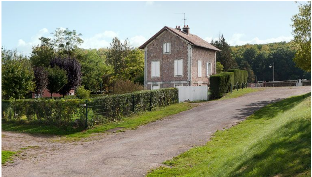
Vue de la maison de garde.
