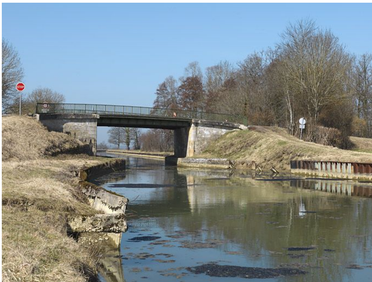
Vue d'ensemble du pont.
