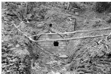
Entrée Saint-Eloi. Phot. Laurent Poupard IVR43_19883900287Z
