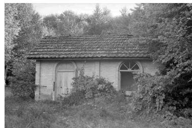
Façade antérieure du bureau dit l'huilerie. Phot. Laurent Poupard IVR43_19883900285Z
