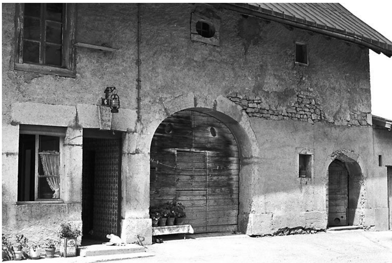
Façade antérieure : vue rapprochée.
