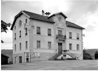
Façade antérieure et face droite.
