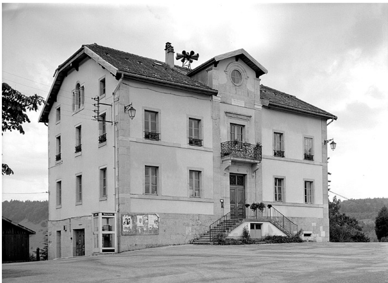
Façade antérieure et face droite.
