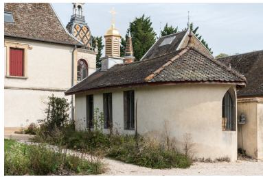
Chapelle : le chœur. Phot. Pierre-Marie Barbe-Richaud IVR26_20222100896NUC4A
