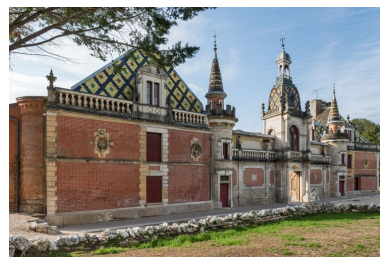
Elévation antérieure, de trois quarts gauche. Phot. Pierre-Marie Barbe-Richaud IVR26_20222100877NUC4A
