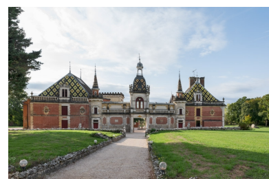
Elévation antérieure (nord). Phot. Pierre-Marie Barbe-Richaud IVR26_20222100878NUC4A
