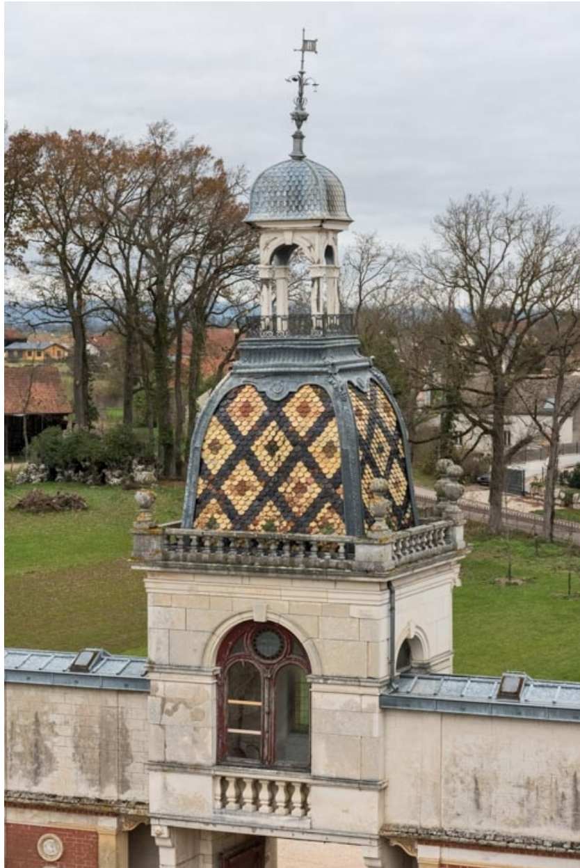
Galerie : pavillon d'entrée, depuis le "Donjon".
