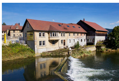
Façades postérieure et latérale droite.
