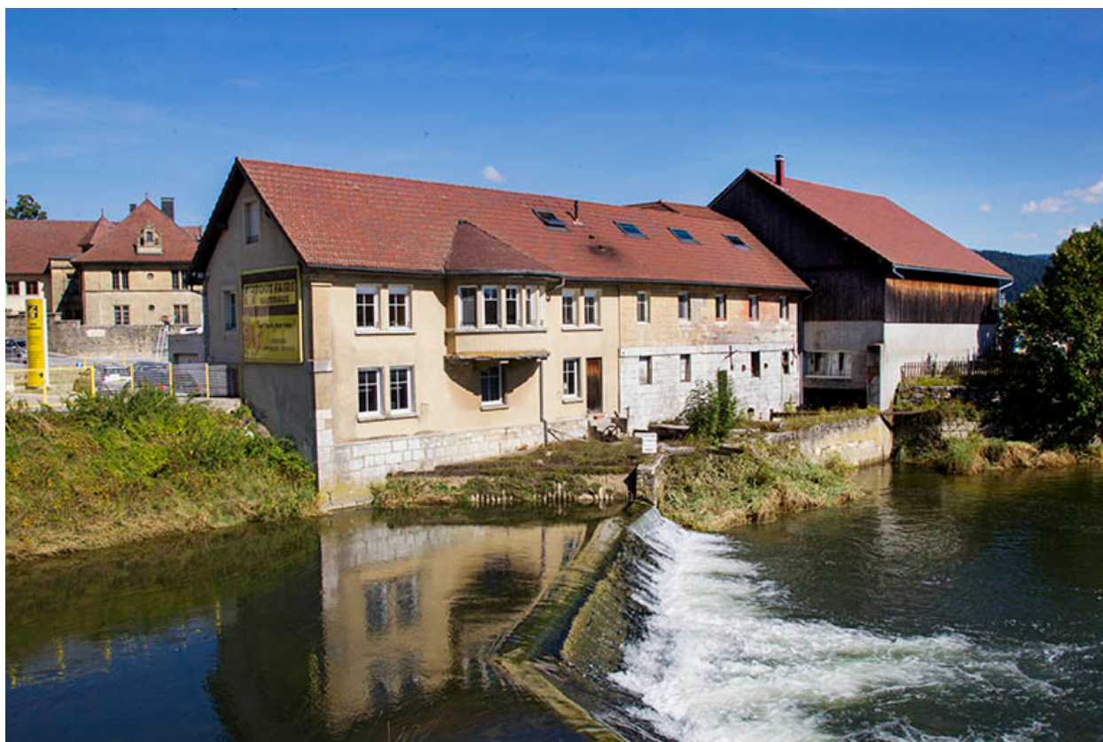
Façades postérieure et latérale droite.
