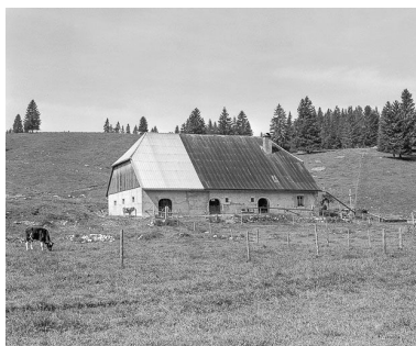
Pignon postérieur et goutterot gauche. Phot. Yves Sancey IVR43_19782500390X
