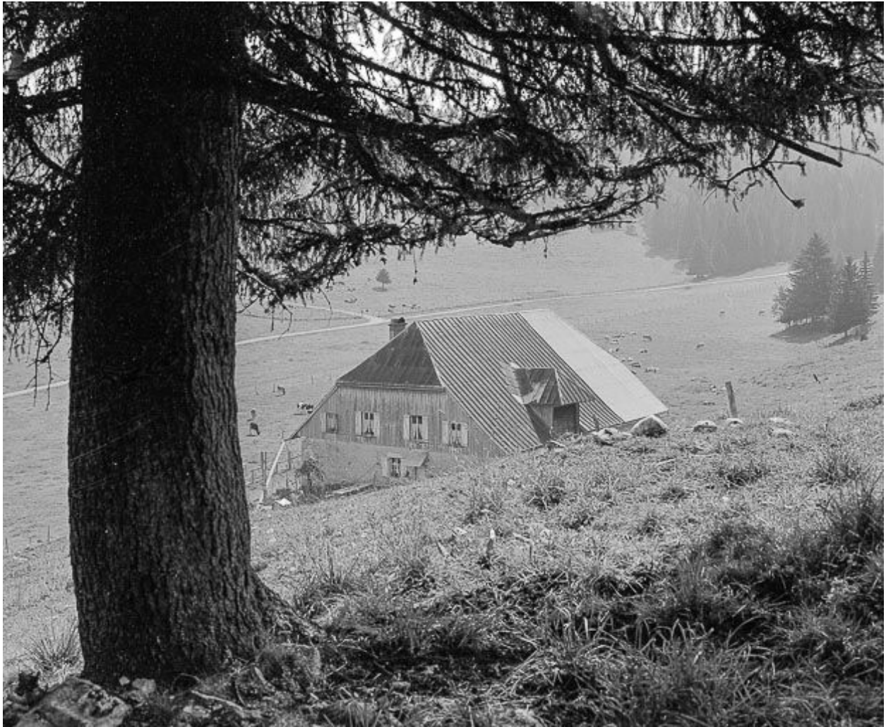
Pignon antérieur et goutterot droit.
