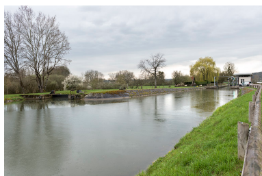
La dérivation et le bassin à radoub. Phot. Sonia Dourlot IVR43_20167000245NUC4A
