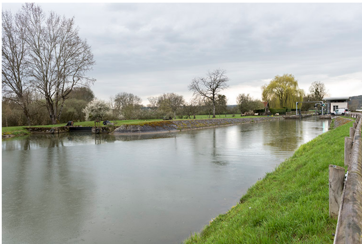
La dérivation et le bassin à radoub.
