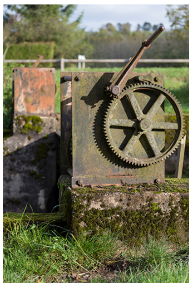
Mécanisme manuel pour ouvrir les portes de l'écluse. Phot. Sonia Dourlot IVR43_20157000148NUC2A
