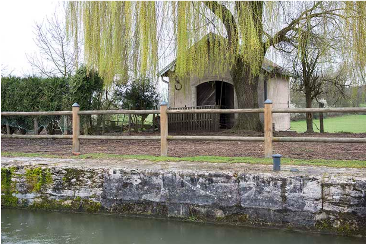
La remise portant la date de 1878.
