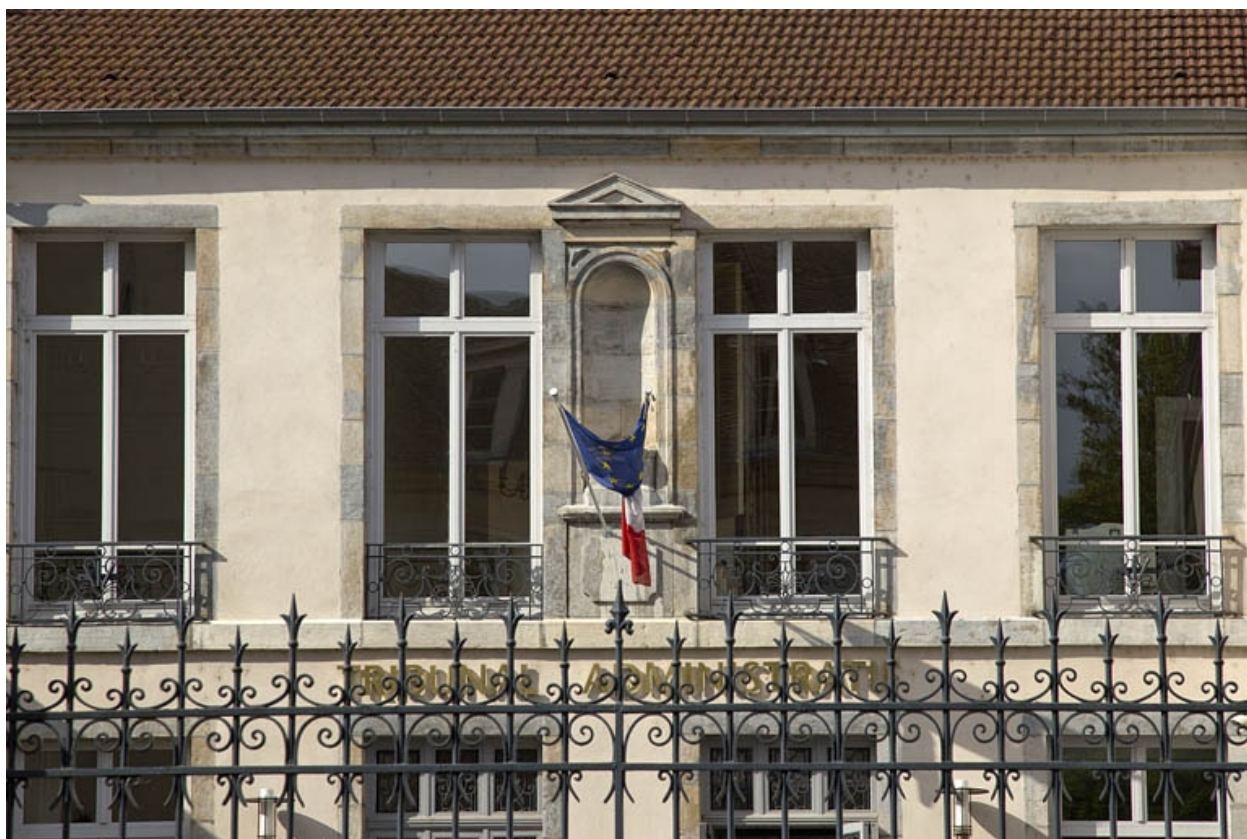
Façade antérieure : détail de la niche.
