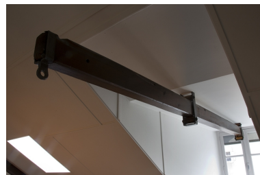
Aile droite, intérieur : détail d'un monte-charge. Phot. Yves Sancey IVR43_20112501758NUC2A
