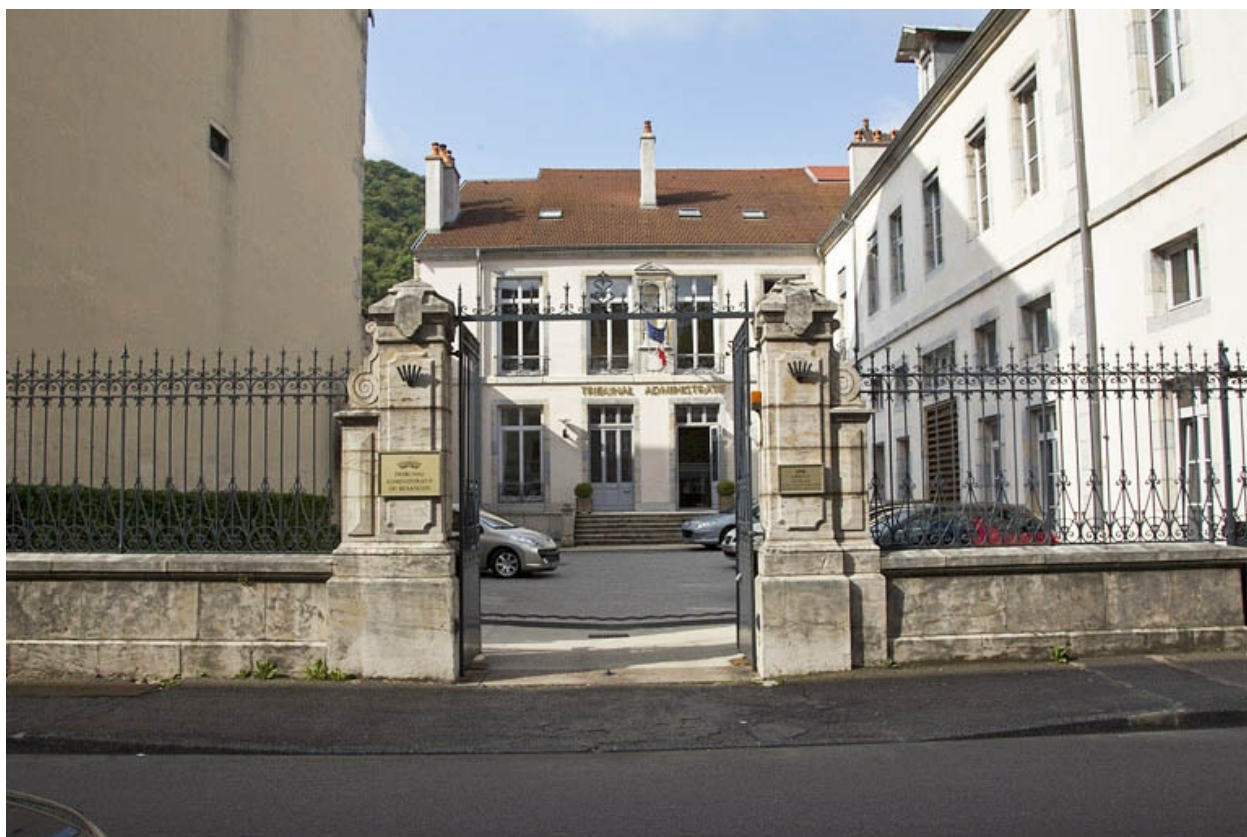
Vue d'ensemble, de face, depuis la rue.
