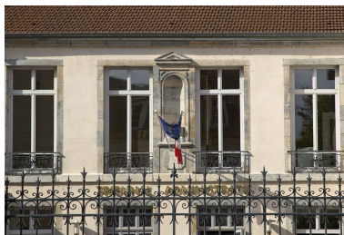
Façade antérieure : détail de la niche. Phot. Yves Sancey IVR43_20112501754NUC2A
