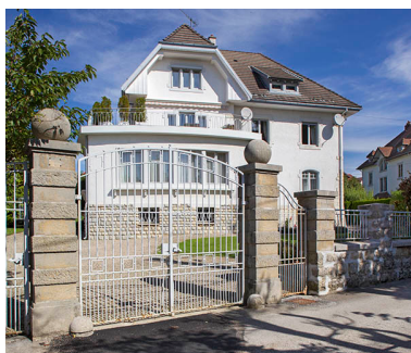
Vue d'ensemble, depuis le sud. Phot. Sonia Dourlot IVR43_20152500738NUC4AQ
