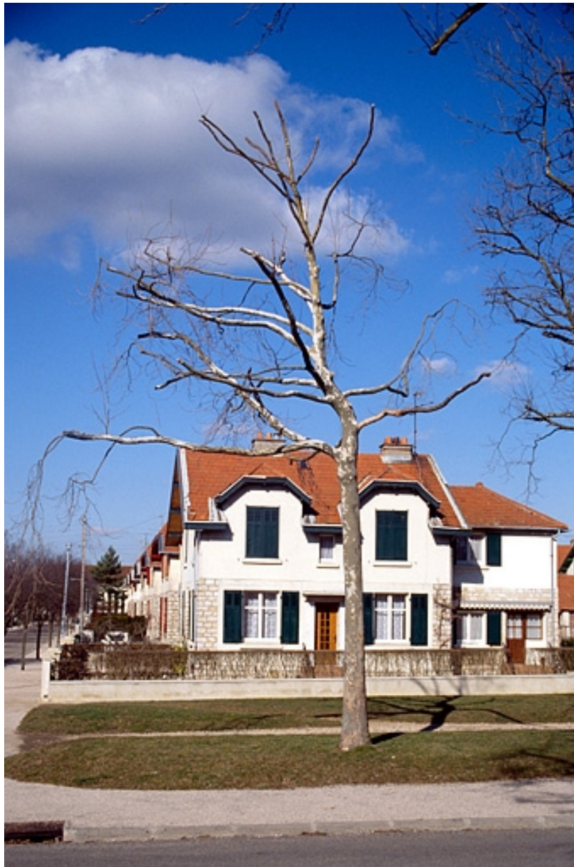
Face latérale droite vue de face.
