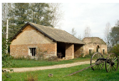
Hangar et grange. Phot. Laurent Poupard IVR43_19883900673ZA
