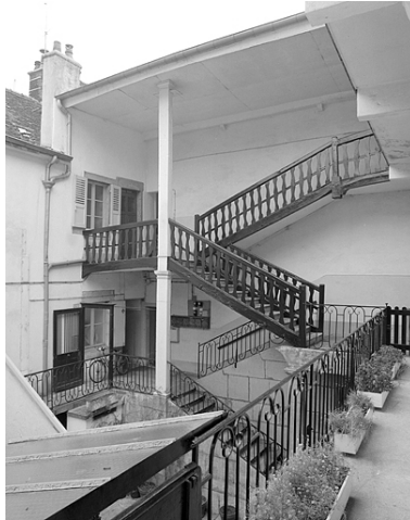
Escalier dans la cour. Phot. Yves Sancey IVR43_19833900644X
