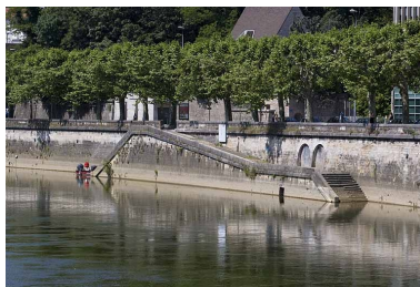
Port Déprez (disparu) : escalier et rampe d'accès à la rivière à son emplacement, depuis l'amont. Les deux baies en arc plein cintre donnaient un accès direct à la rivière en passant sous le quai Veil-Picard. Phot. Yves Sancey IVR43_20062500248NUCA
