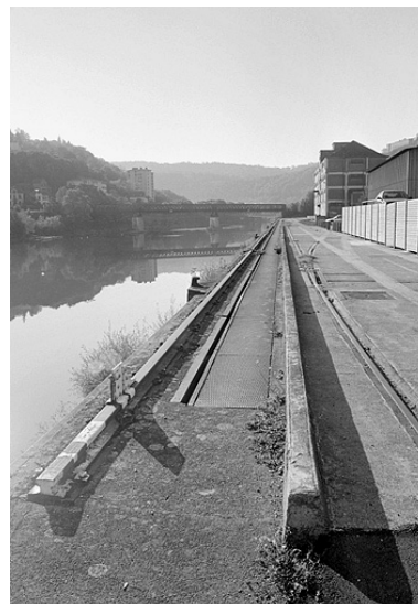
Port fluvial : quai et vestiges de la voie de roulement de la grue mobile, depuis l'aval. Phot. Jérôme Mongreville IVR43_20032500182X
