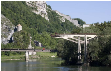
Port de l'usine dite des Soieries puis de la Rhodiacéta : portique en béton du pont roulant. Phot. Yves Sancey IVR43_20062500153NUCA
