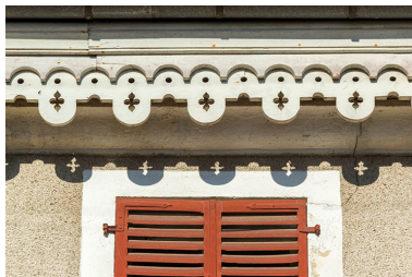
Détail du lambrequin. Phot. Sonia Dourlot IVR43_20157001397NUC2A
