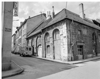
Maisons situées rue Montrieux. Phot. Yves Sancey IVR43_19802500296X
