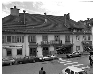
Maison située 9 rue de la Halle. Phot. Yves Sancey IVR43_19812500171X
