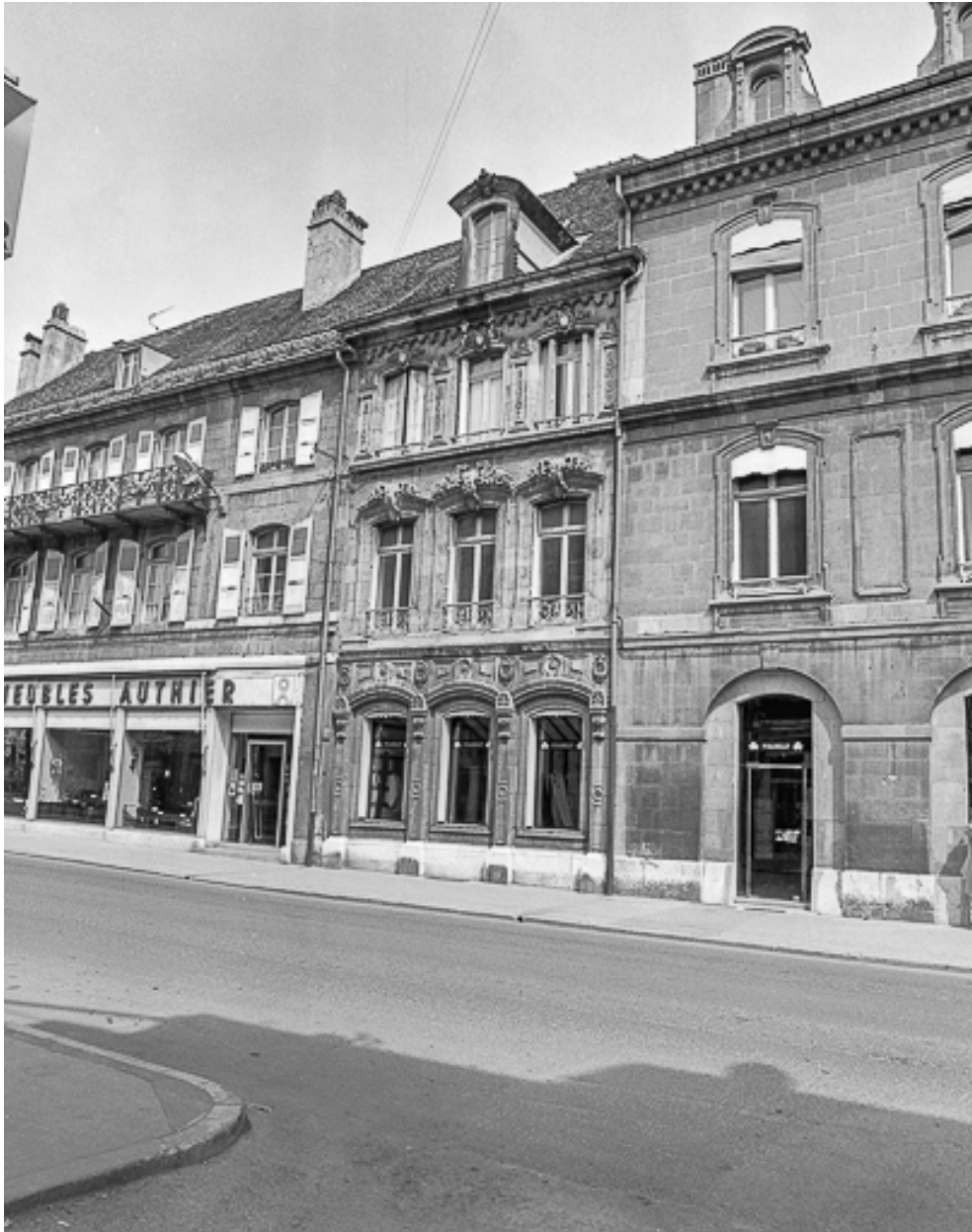
Maisons situées 8 bis rue de la République.
