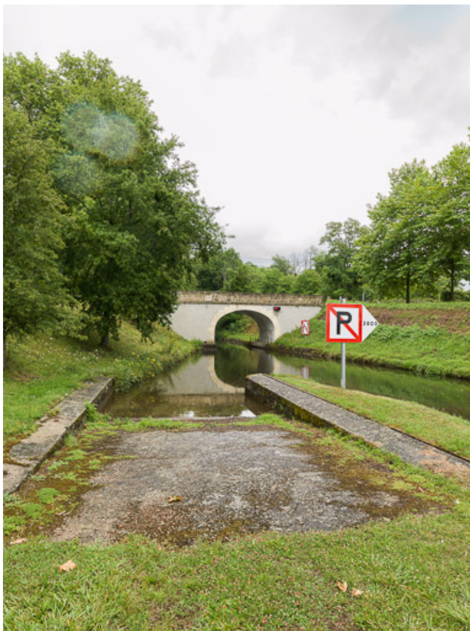
Vue d'ensemble du pont.
