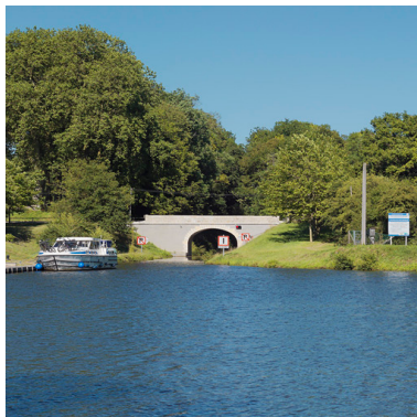
Pont vu de l'Etang de Baye. Phot. Thierry Kuntz IVR26_20135800487NUC2A
