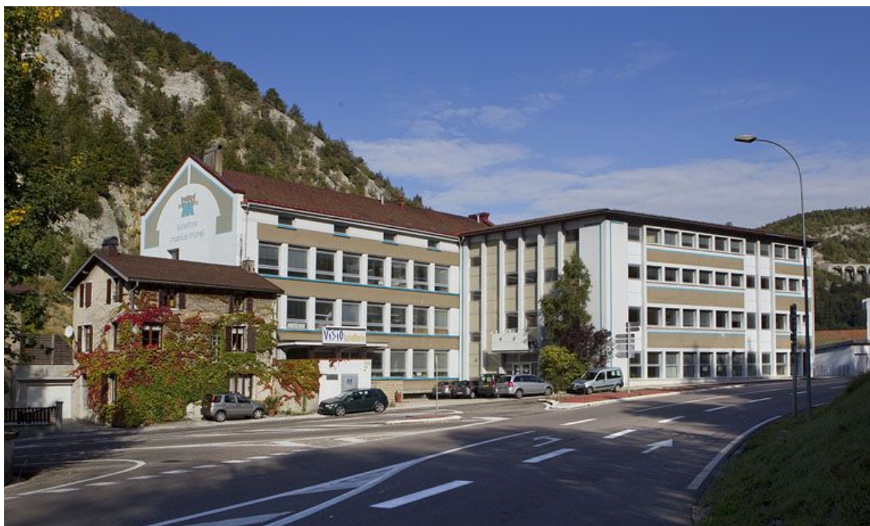
Vue d'ensemble de la façade antérieure.
