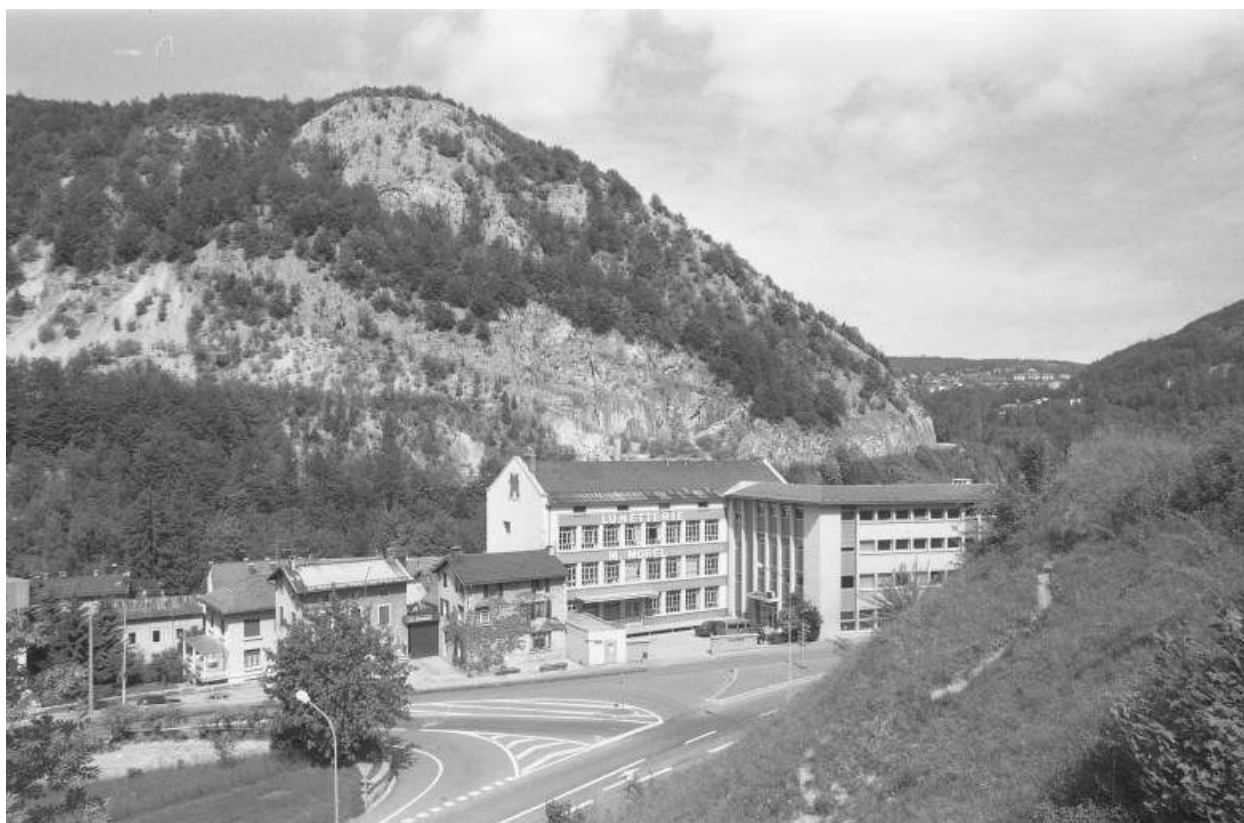
Vue d'ensemble de la façade antérieure.
