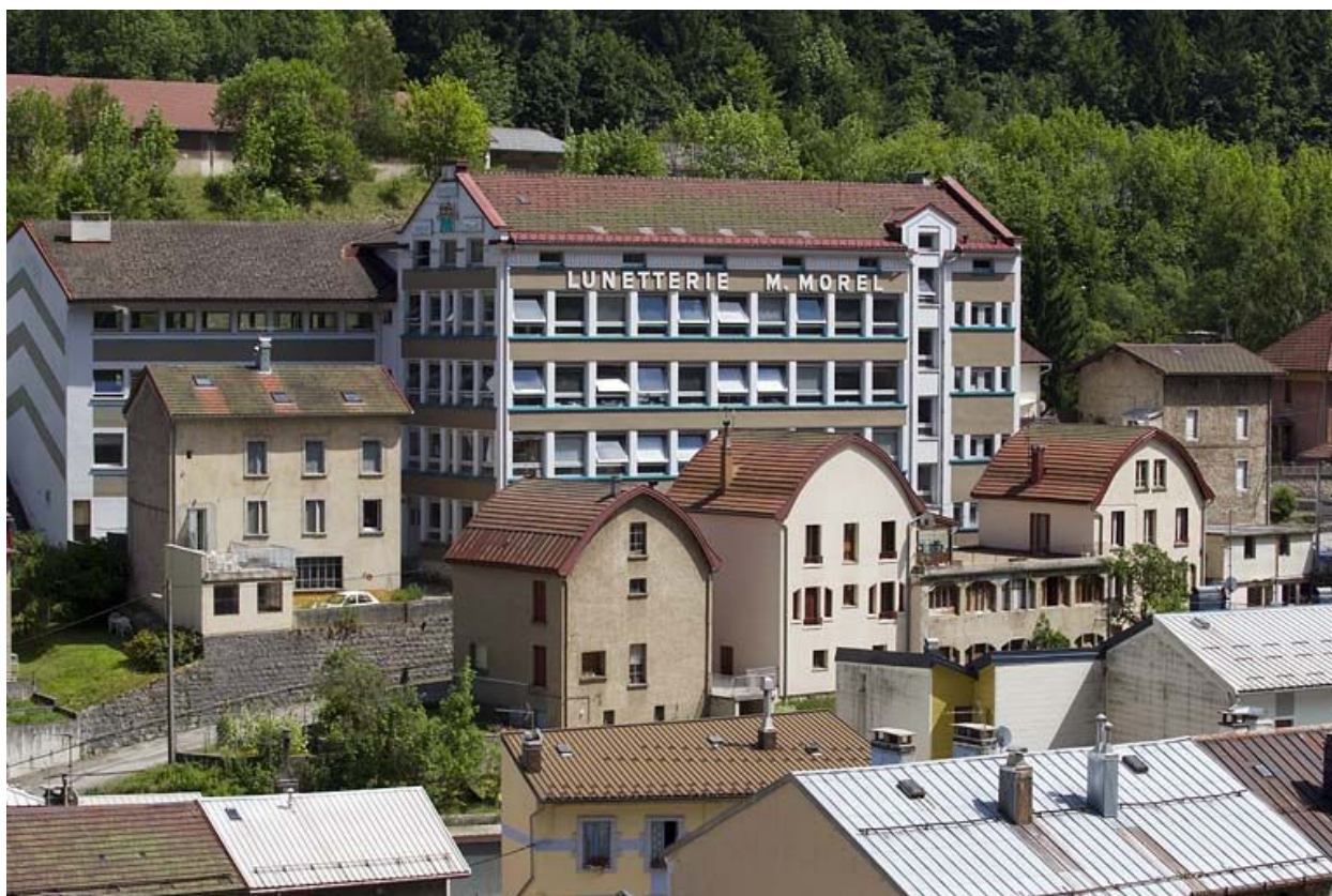
Vue d'ensemble de la façade postérieure.
