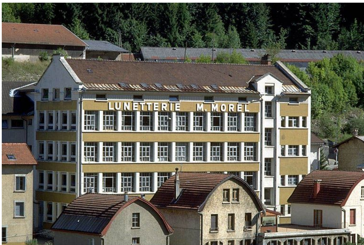
Façade postérieure de l'atelier de 1936.
