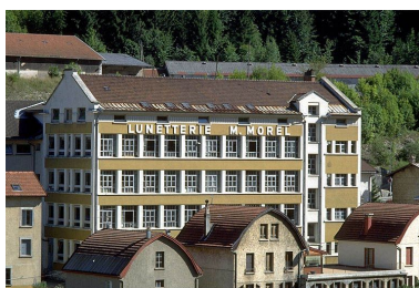
Façade postérieure de l'atelier de 1936. Phot. Laurent Poupard IVR43_19913901456ZA
