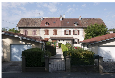
Façade ouest d'une habitation. Phot. Jérôme Mongreville IVR43_20112502032NUC4A
