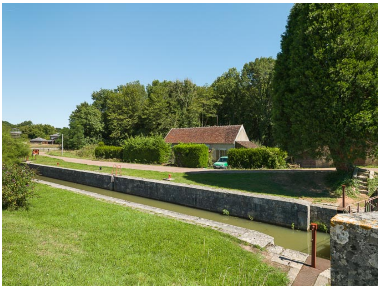
Vue du site d'écluse.
