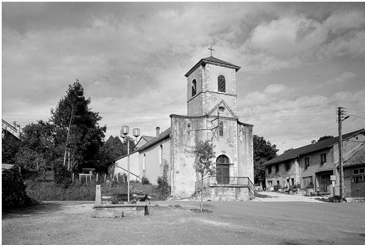
Extérieur : façade ouest et face sud.
