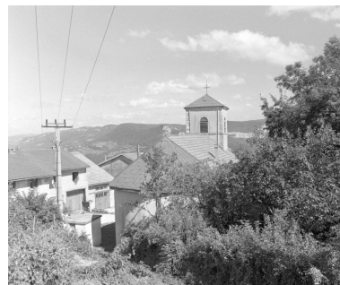
Extérieur : l'abside vue depuis le nord-est. Phot. Yves Sancey IVR43_19943900948X
