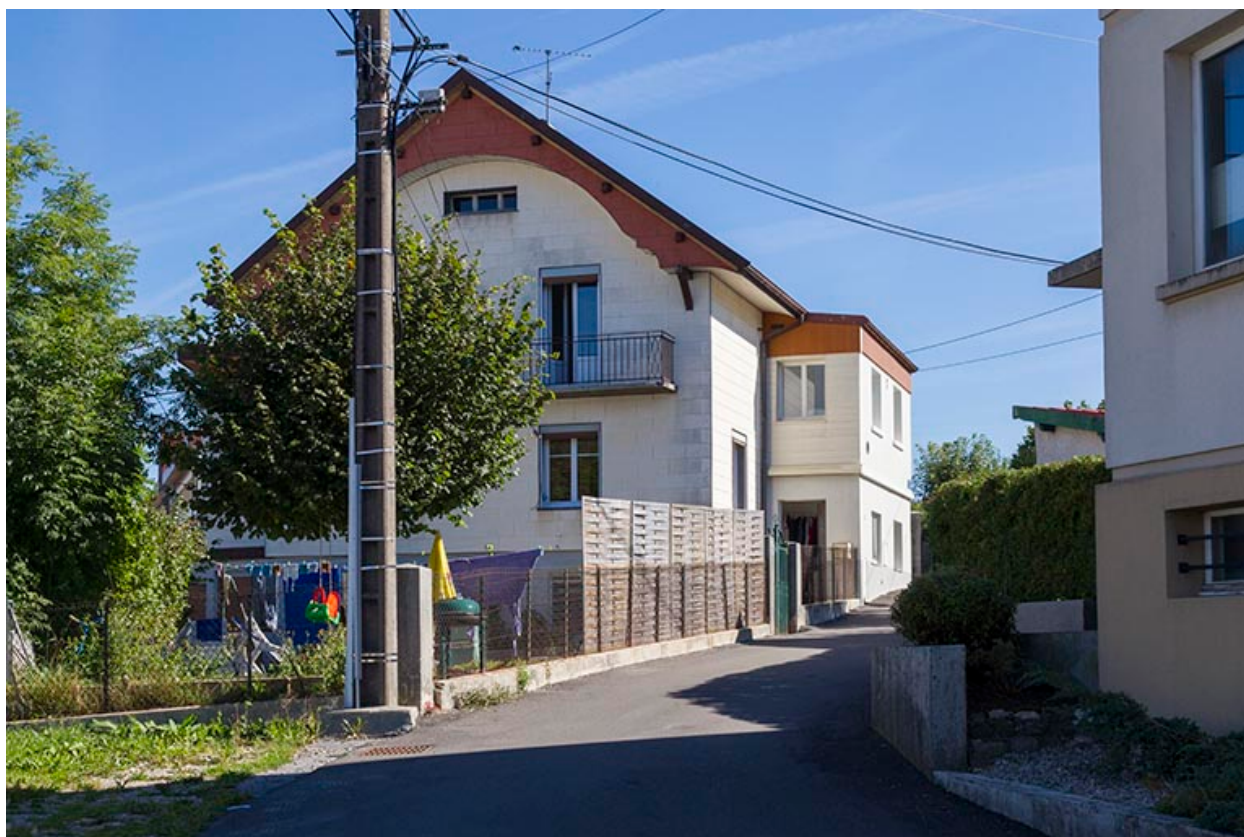
Maison : élévation ouest.
