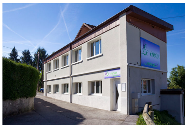
Atelier : élévations nord et est. Phot. Yves Sancey IVR43_20132502021NUC2A
