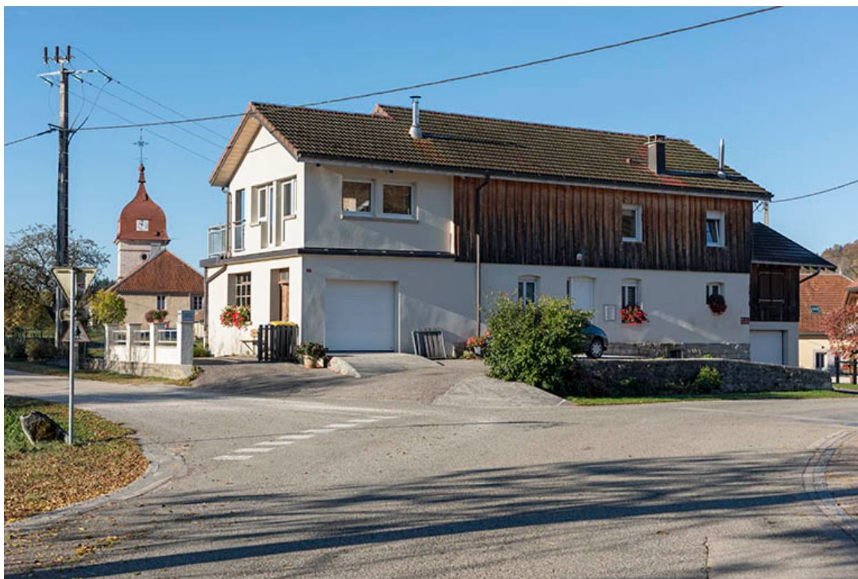
Façades antérieure et latérale gauche.
