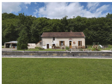
Maison éclusière vue de face. Phot. Thierry Kuntz IVR26_20122102297NUC4A
