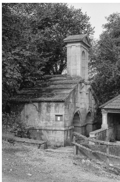
Détail : la fontaine. Phot. Bernard Lardière IVR43_19797000256Z
