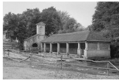
Vue d'ensemble. Phot. Bernard Lardière IVR43_19797000255Z
