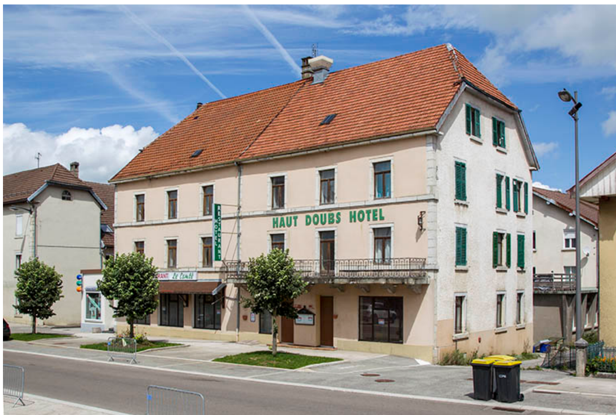
Façades antérieure et latérale droite.
