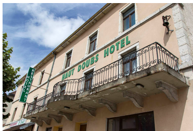
Façade antérieure : balcon. Phot. Sonia Dourlot IVR43_20152500878NUC2A
