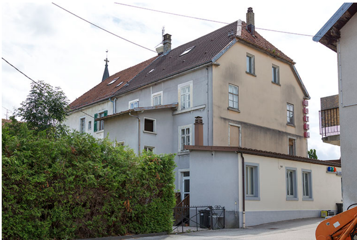
Façades postérieure et latérale gauche.
