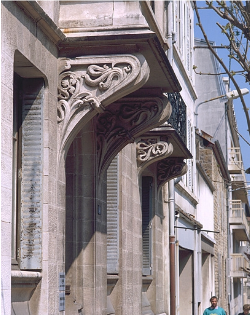
Détail des consoles de l'oriel.
