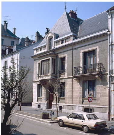
Façade antérieure. Phot. Yves Sancey IVR43_19883900111XA
