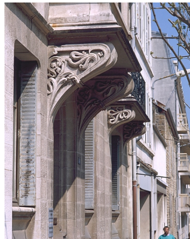
Détail des consoles de l'oriel. Phot. Yves Sancey IVR43_19883900112XA
