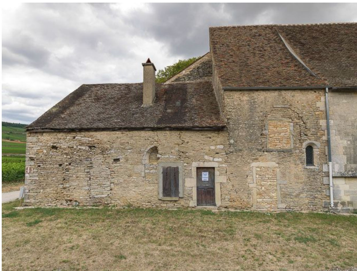
Vue du pignon sud.
