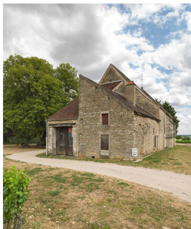
Vue de la façade ouest. Phot. Pierre-Marie Barbe-Richaud IVR26_20152101430NUC4A
