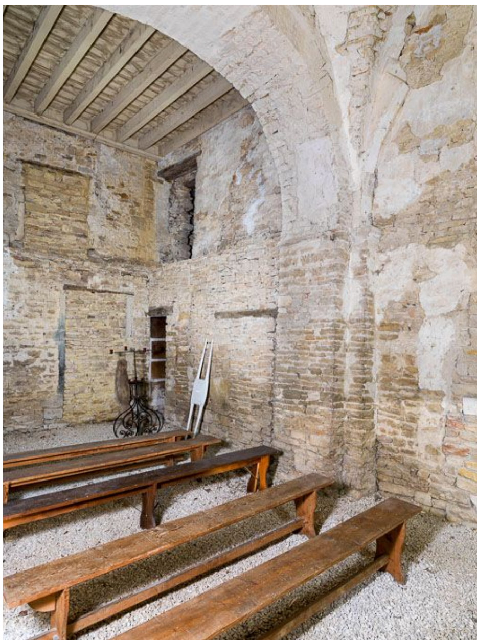
Ancienne chapelle : vue de l'angle sud-ouest.
