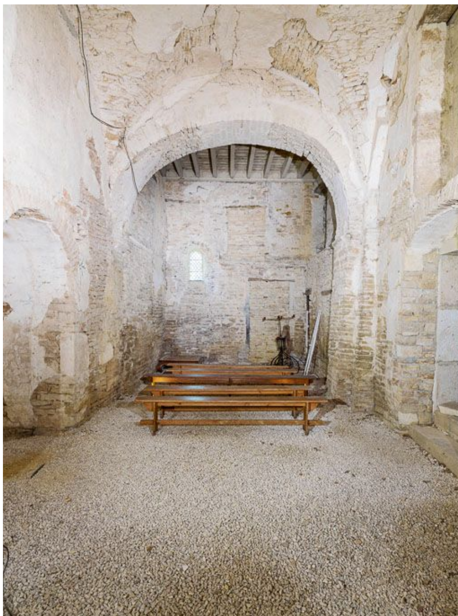
Ancienne chapelle : vue vers le Sud.
