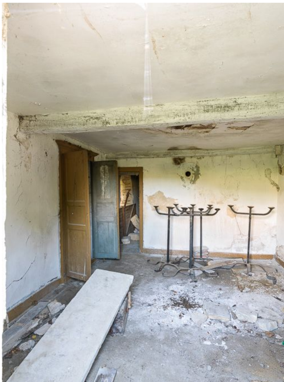
Vue d'un ancien logement (rez-de-chaussée).
