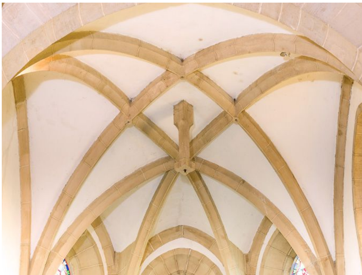
Vue de la voûte du chœur.
