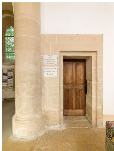
Vue de la porte de la sacristie. Phot. Pierre-Marie Barbe-Richaud IVR26_20152100574NUC4A
