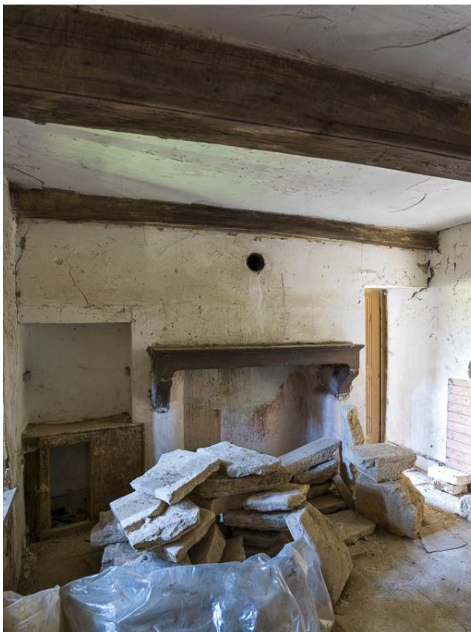
Vue d'un ancien logement (rez-de-chaussée).
