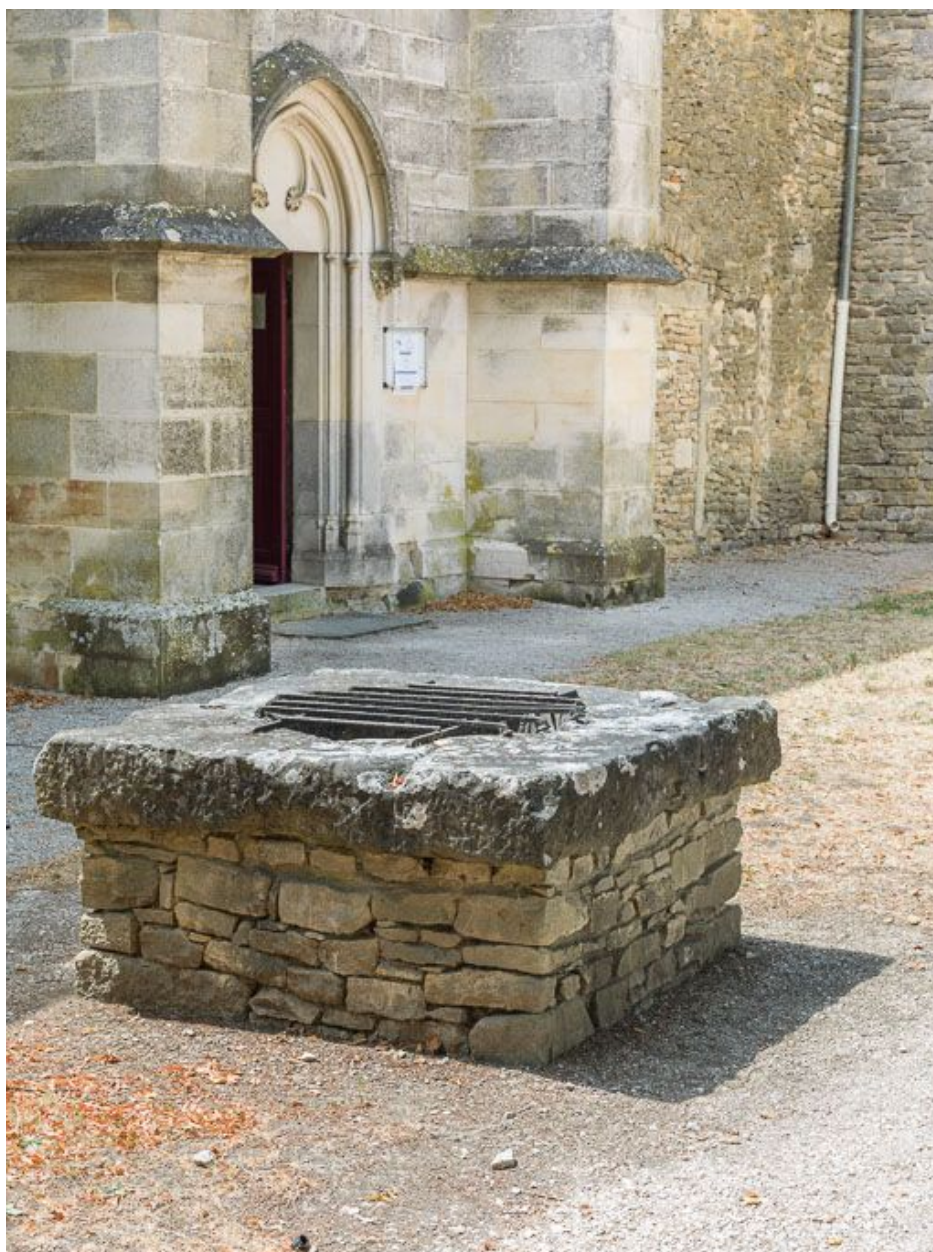
Puits : vue d'ensemble.
