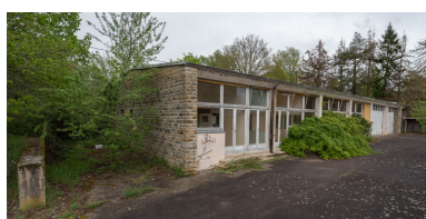
Bâtiment des garages et des ateliers.
