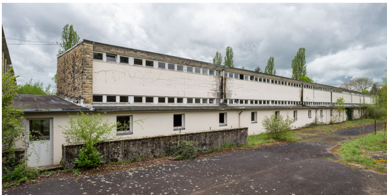
Élévation extérieure de l'aile Bellevue, côté nord.
