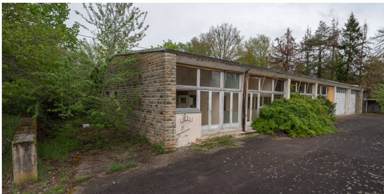
Bâtiment des garages et des ateliers.
