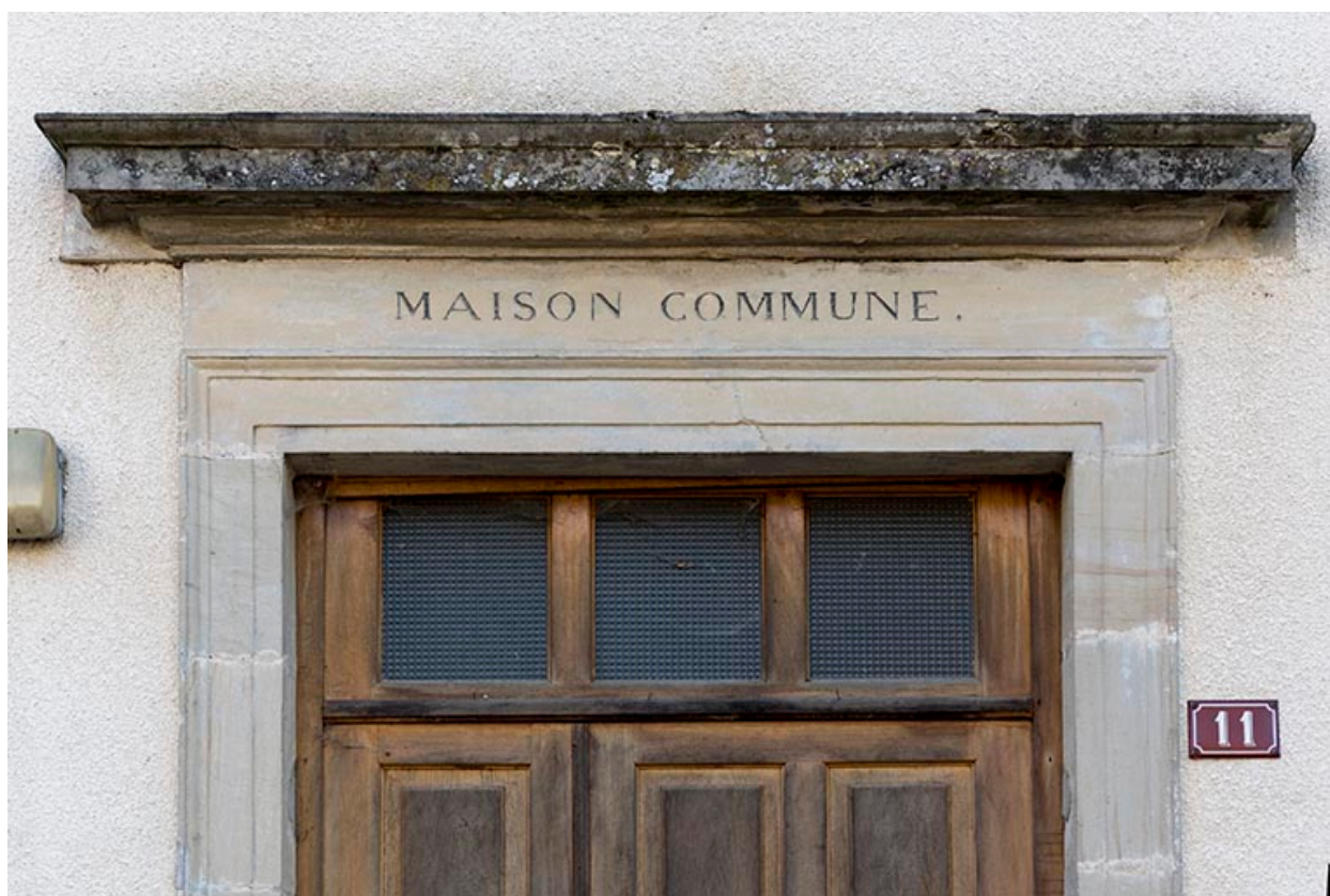
Pignon est : détail du linteau de l'entrée.
