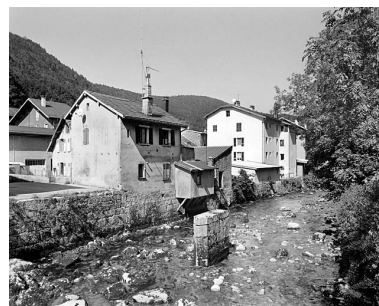
Vue d'ensemble, depuis le sud- est : élévations postérieures. Phot. Yves Sancey IVR43_20033900347X
