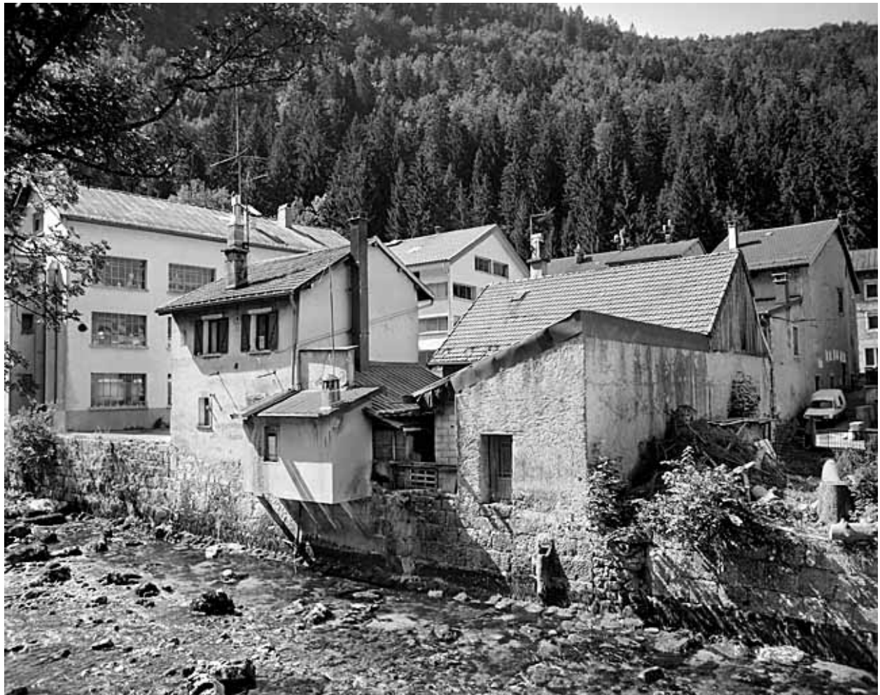
Vue d'ensemble, depuis le nord-est : élévations postérieures.
