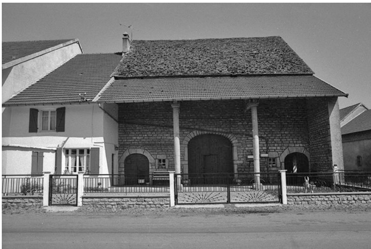
Ferme située 13 route de Crançot.
