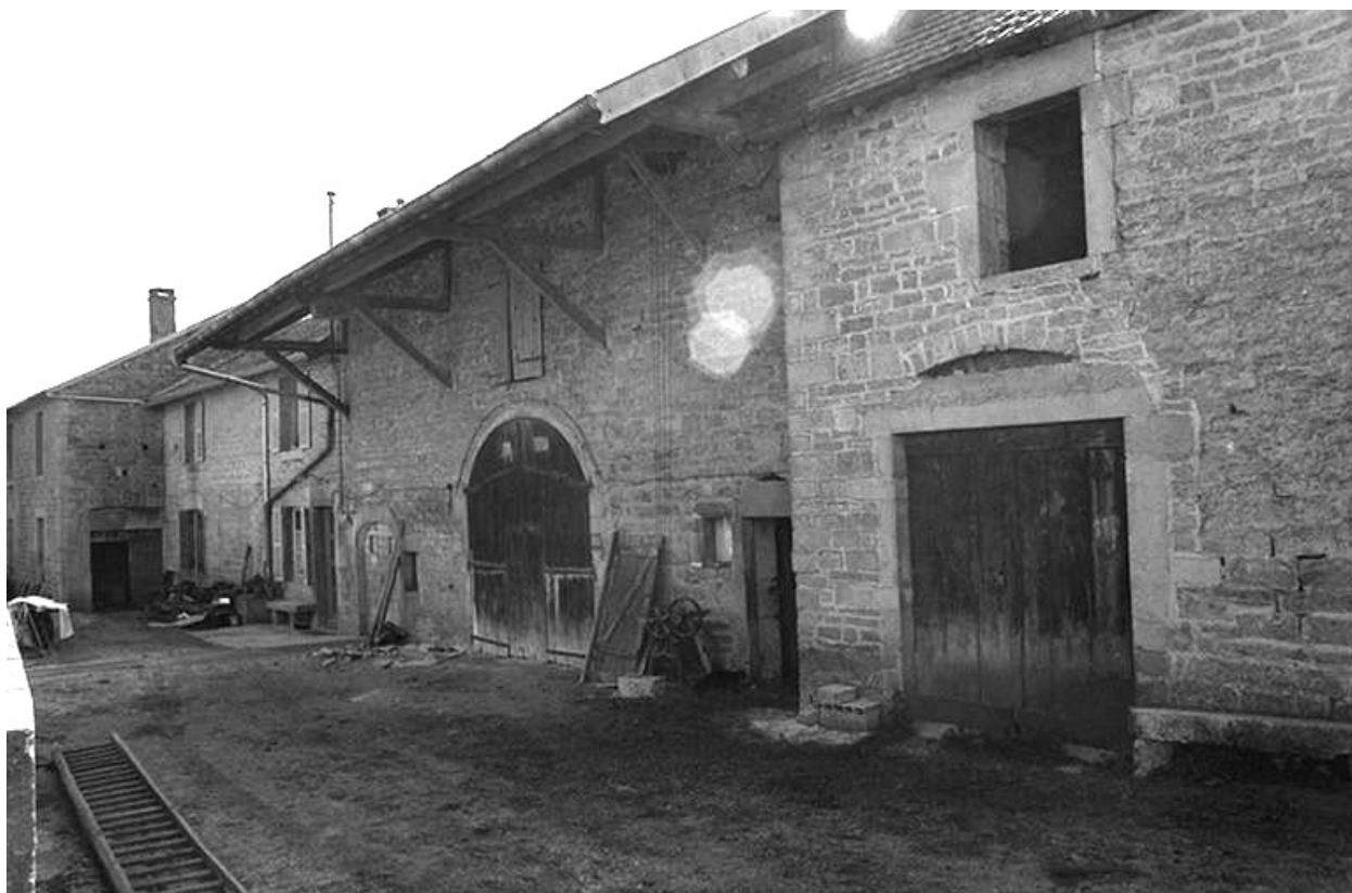
Ferme située le long du chemin de grande communication n° 96 de Plasne à Mirebel.
