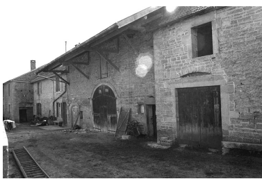
Ferme située le long du chemin de grande communication n ° 96 de Plasne à Mirebel. Phot. F. Pernin IVR43_19743900194Z
