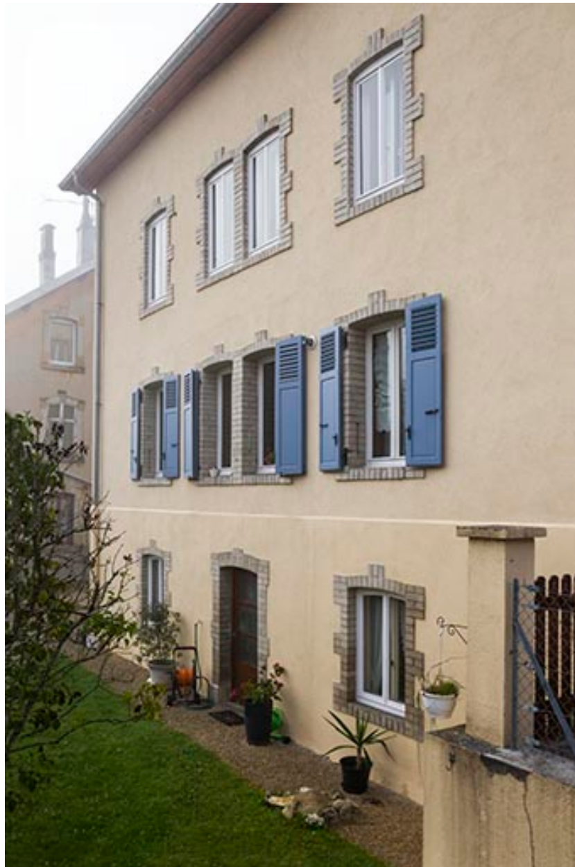
Façade postérieure, vue en enfilade.
