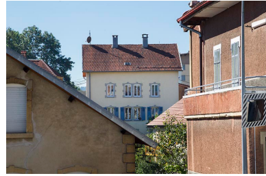
Façade postérieure (vue éloignée). Phot. Yves Sancey IVR43_20132502146NUC2A
