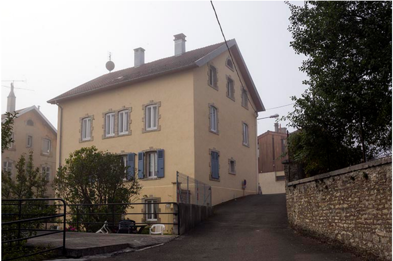
Façades postérieure et latérale gauche.
