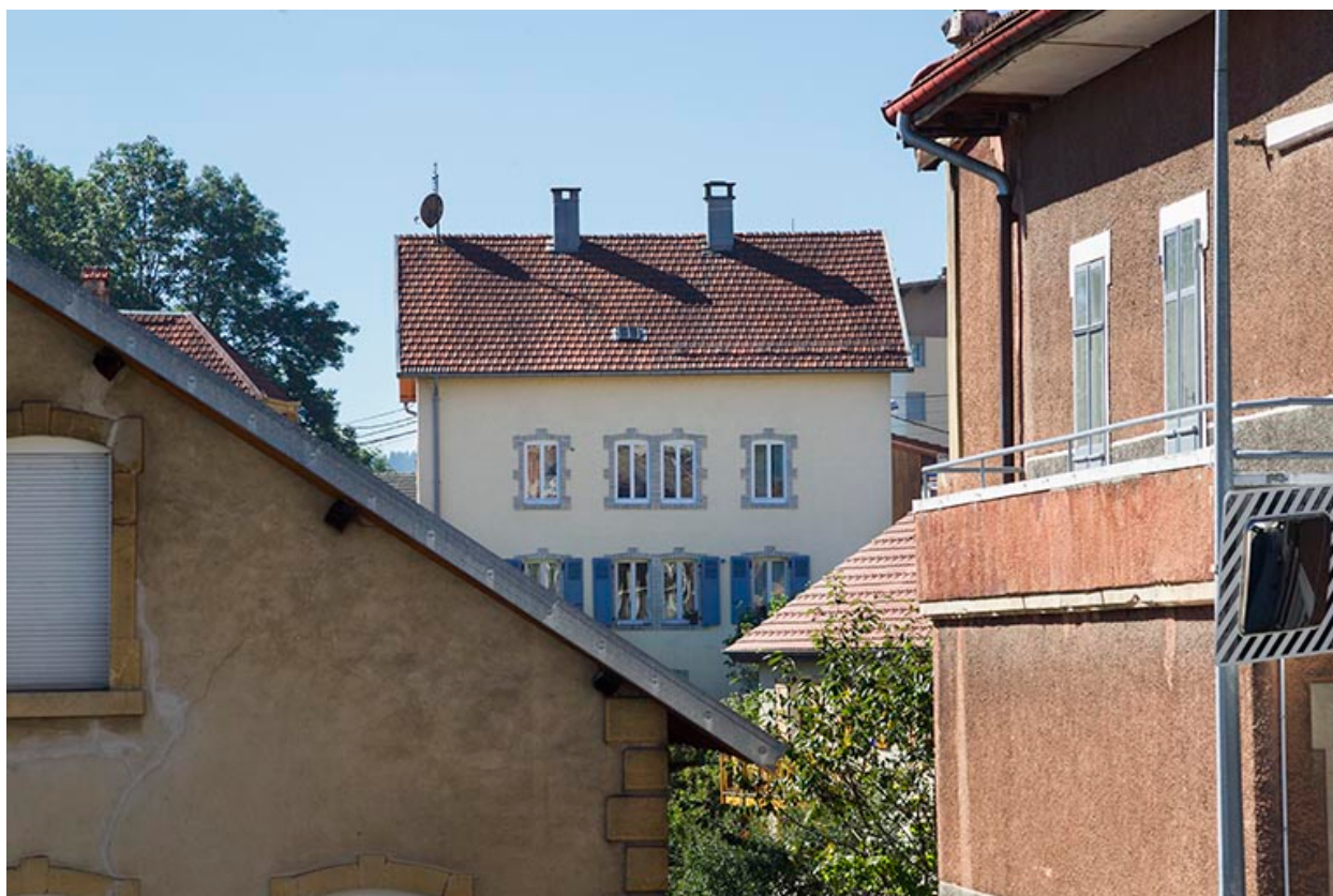
Façade postérieure (vue éloignée).
