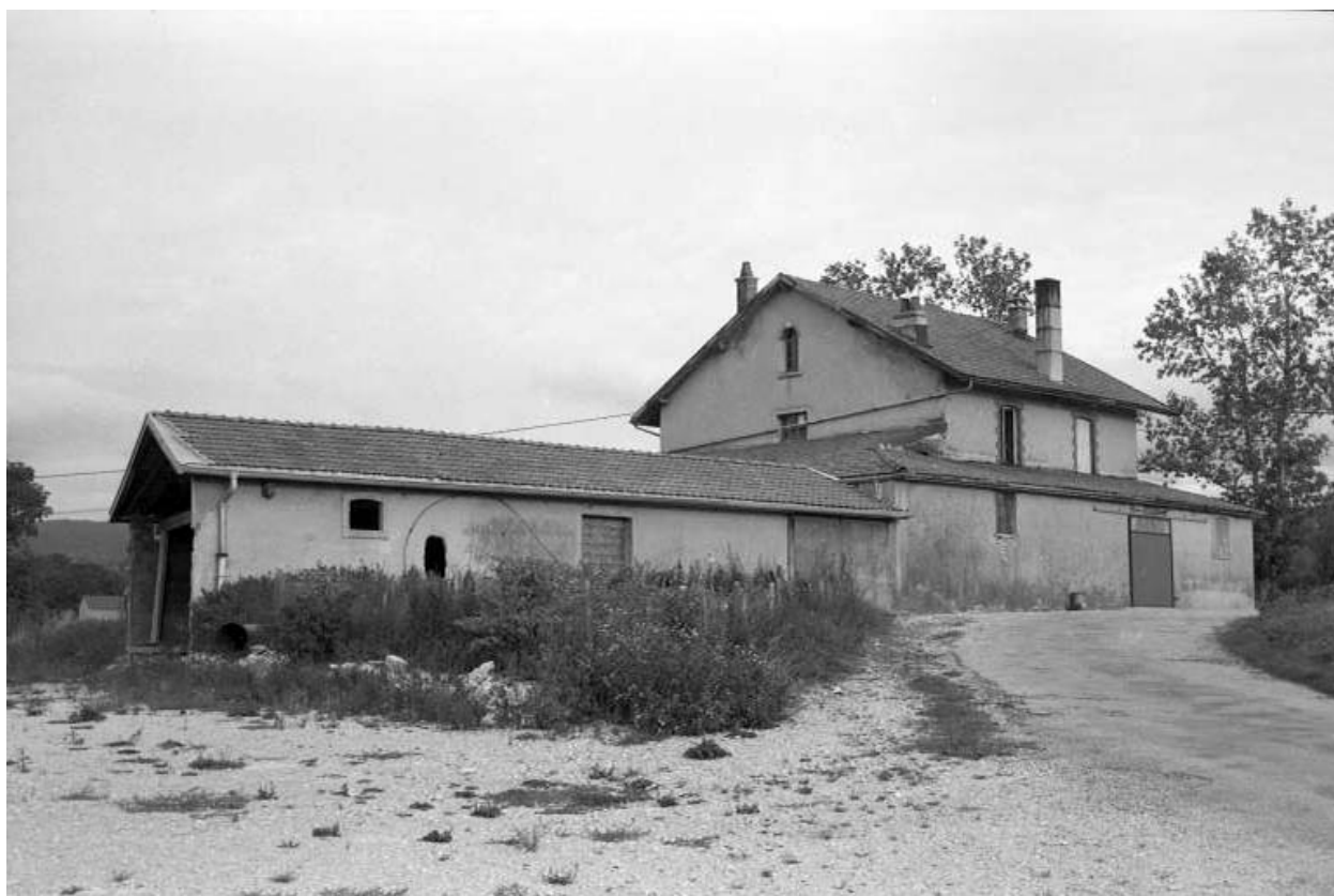
Façades postérieure et latérale gauche, et bûcher.
