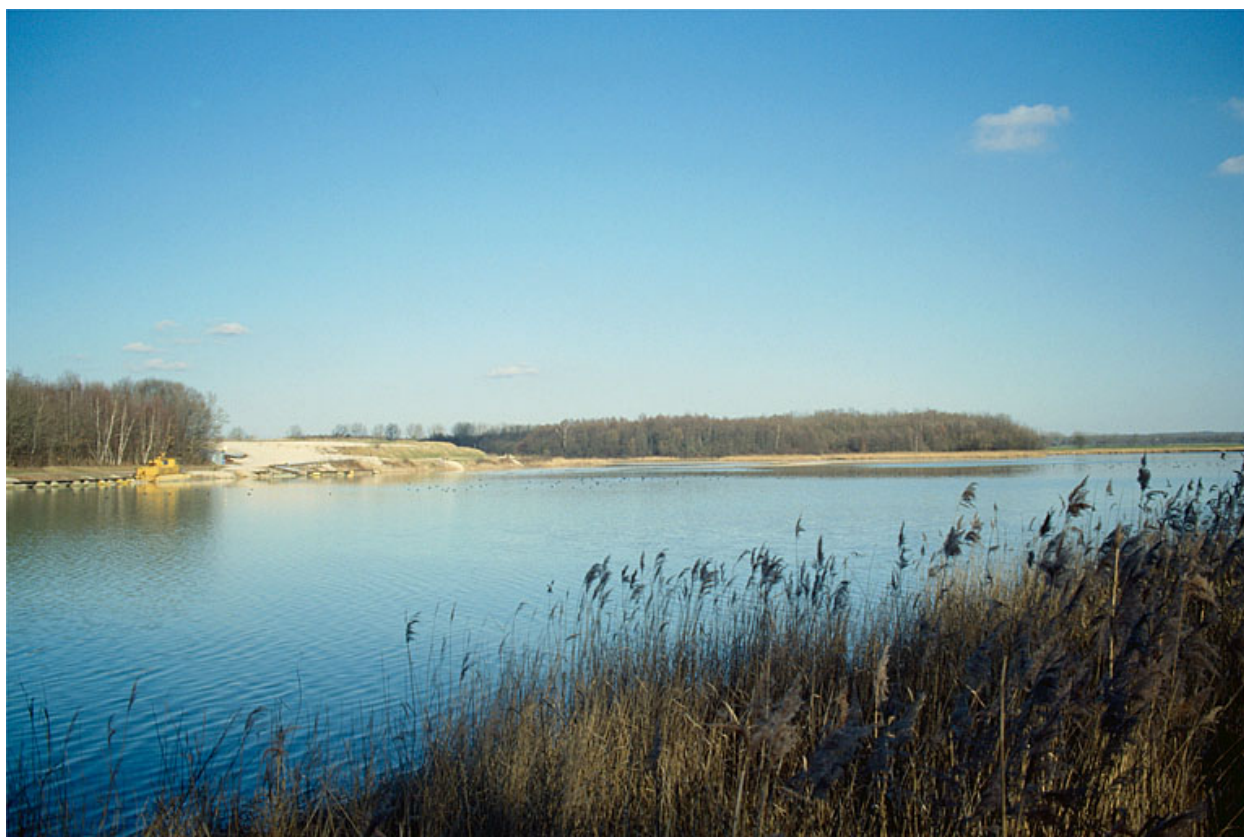
Etang de l'Aillon vu du sud-ouest.
