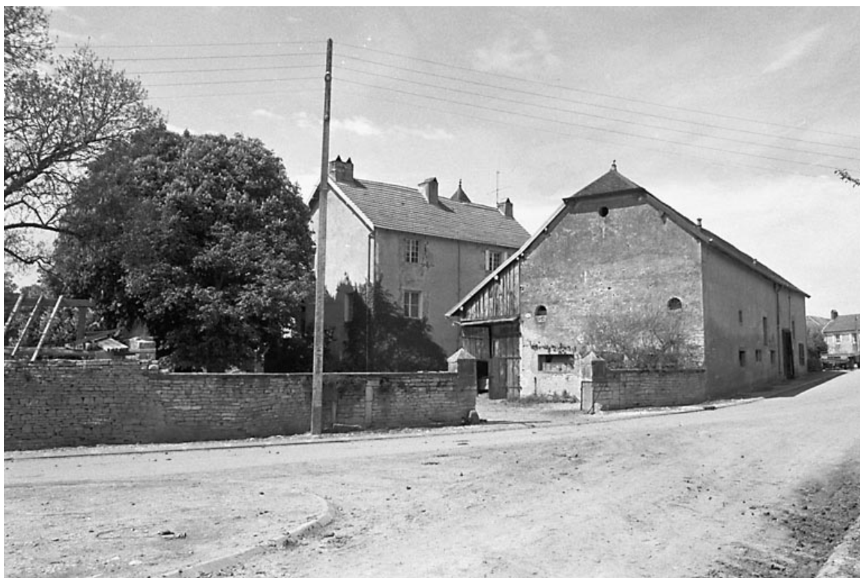
Ferme située rue des Clos.
