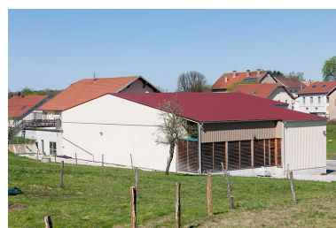
Extension des caves d'affinage. Phot. Jérôme Mongreville IVR43_20152501026NUC4A
