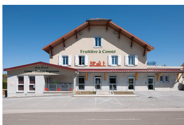
Vue de face. Phot. Jérôme Mongreville IVR43_20152501030NUC4A
