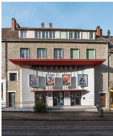
Côte-d'Or, Châtillon-sur-Seine. Immeuble et cinéma Le Sélect. Phot. Pierre-Marie Barbe-Richaud IVR26_20212100367NUC2A
