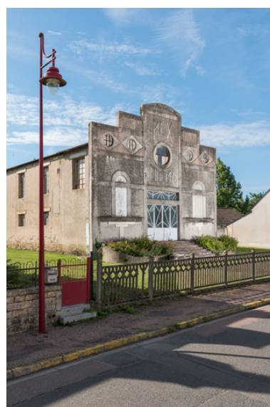
Nièvre, Guéigny. Cinéma Rex. Phot. Pierre-Marie Barbe-Richaud IVR26_20235800166NUC4A
