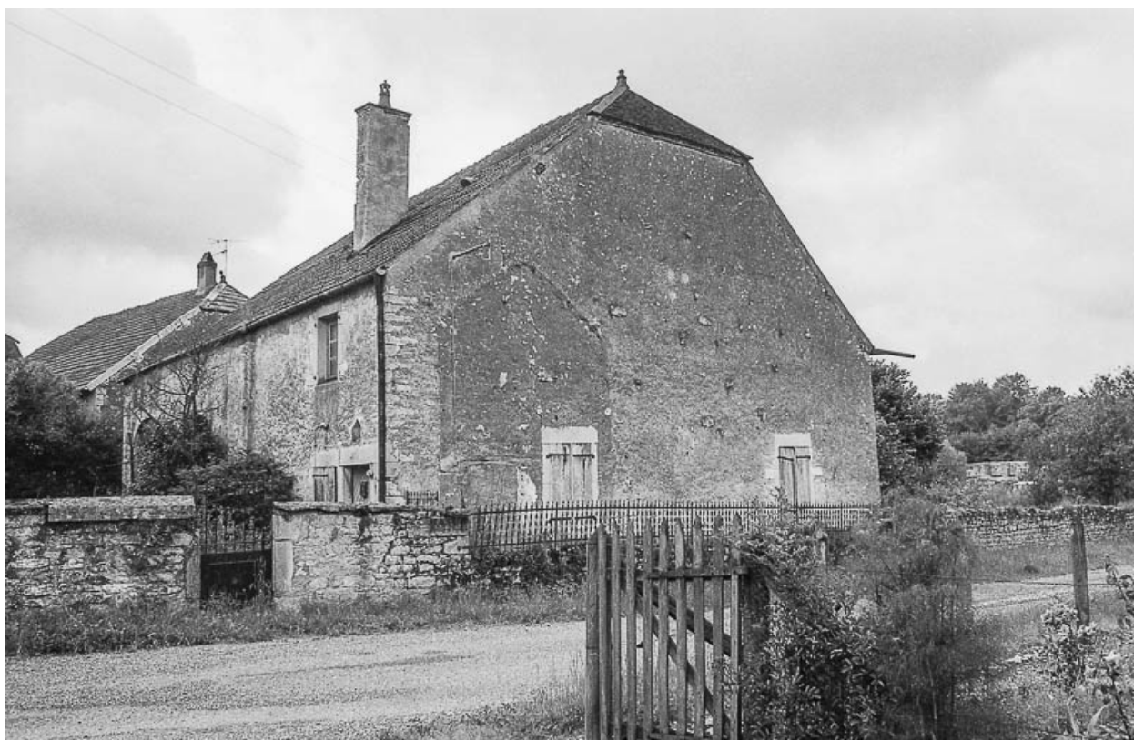
Ferme 4 : bâtiment d'habitation.
