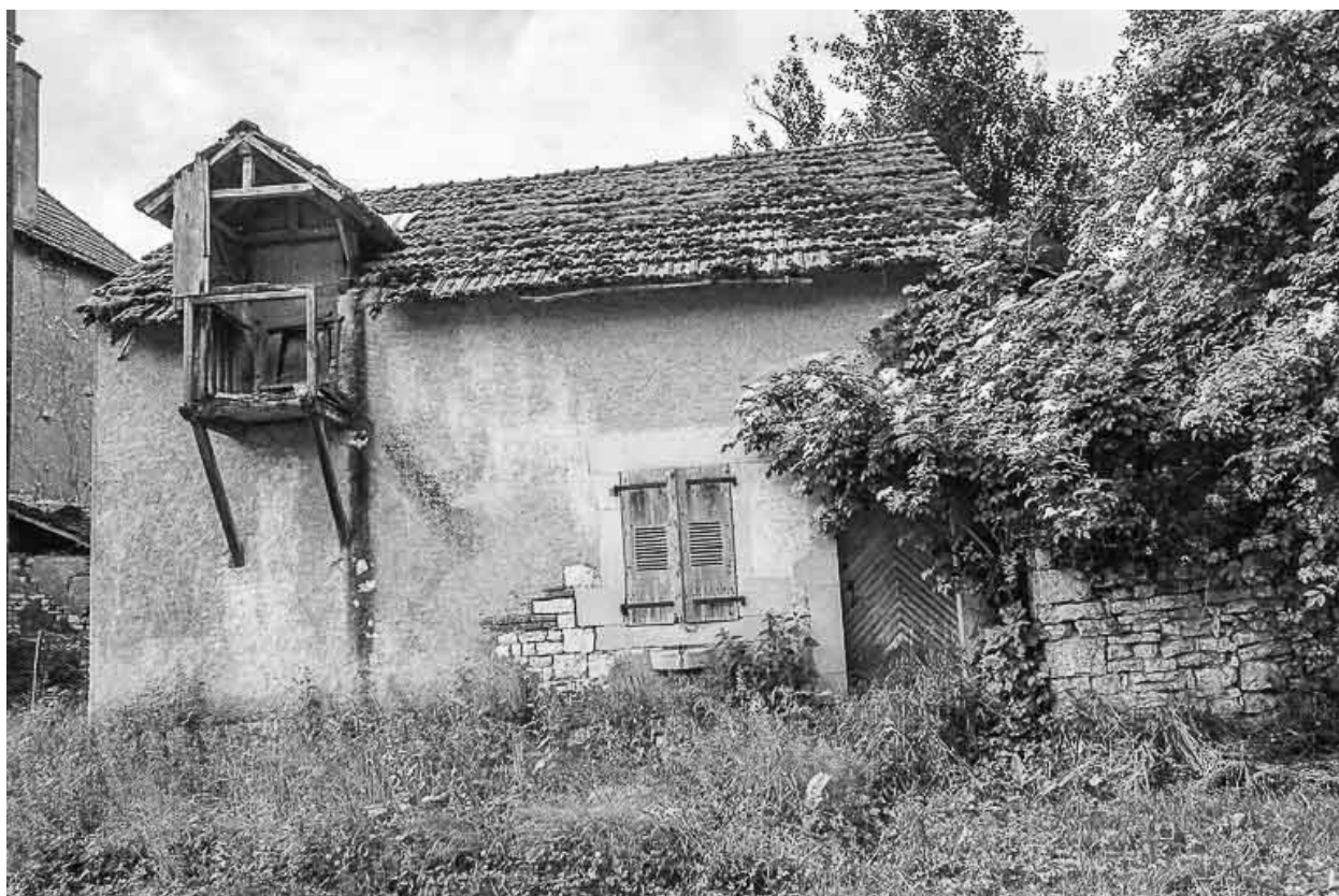
Maison cadastrée 1979 AB 10 : façade antérieure.
