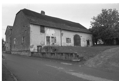
Ferme-bloc à trois travées. Phot. Bernard Lardière IVR43_19817000277Z
