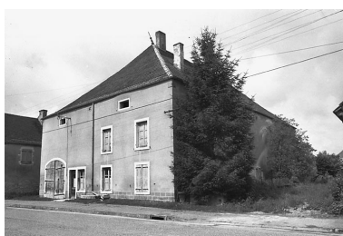
Ferme 3 : façade antérieure sur rue. Phot. Bernard Lardière IVR43_19817000267Z
