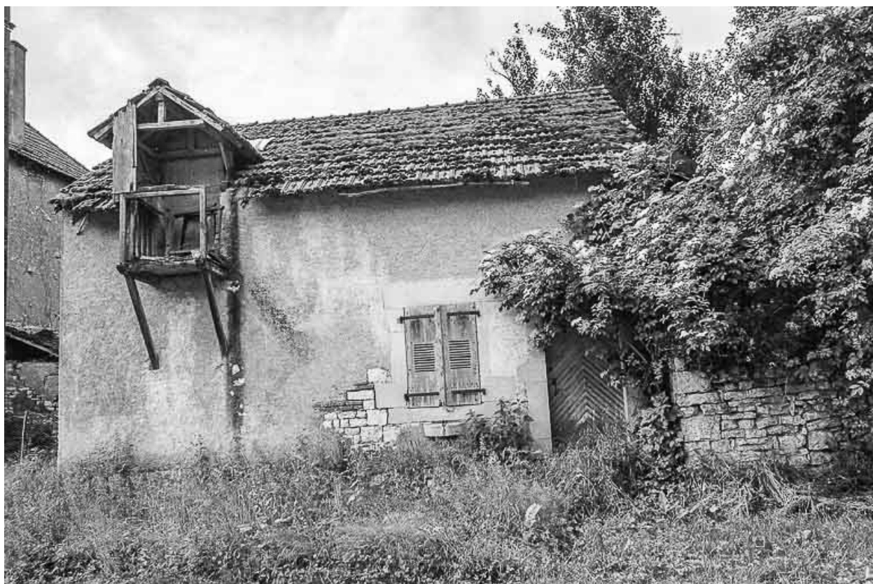
Maison située à Broye-lès-Pesmes : façade antérieure.
